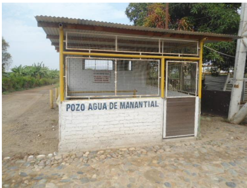
Figura 16. Pozo tubular de la empresa productora de ron (Parte 1)
