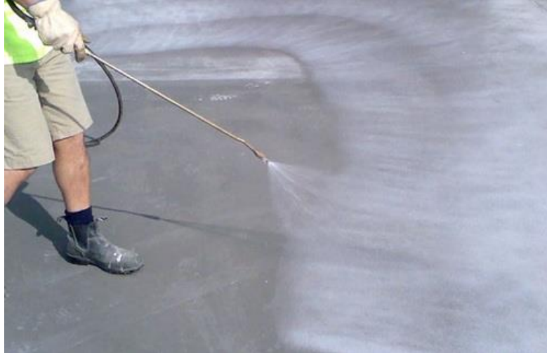
Imagen 8. Aplicación del aditivo curador por aspersión, uno de los rendimientos más comunes es de 1 litro cada 5m 2 .
