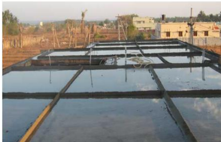
Imagen 9. Curado por inundación en una losa ayudado por diques de arena, método muy poco amigable con el medio ambiente.
