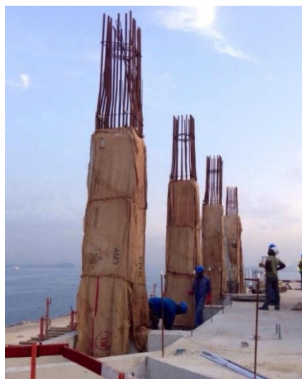
Imagen 6. Curado de columnas mediante lonas húmedas, amortigua la responsabilidad de riego periódico.
