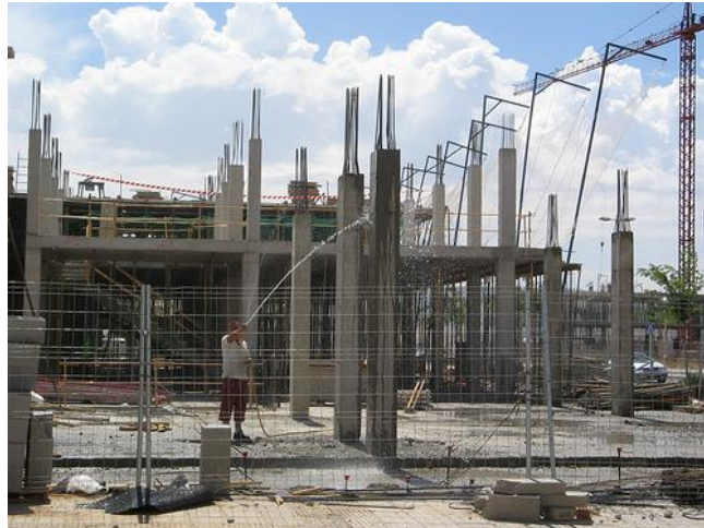
Imagen 5. Curado periódico mediante riego, se observa la dificultad de aplicación para elementos verticales.
