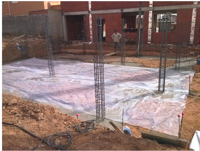
Imagen 7. Curado mediante membrana de polietileno, al ser un material impermeable no permite el escape de agua mezcla por evaporación en el concreto.
