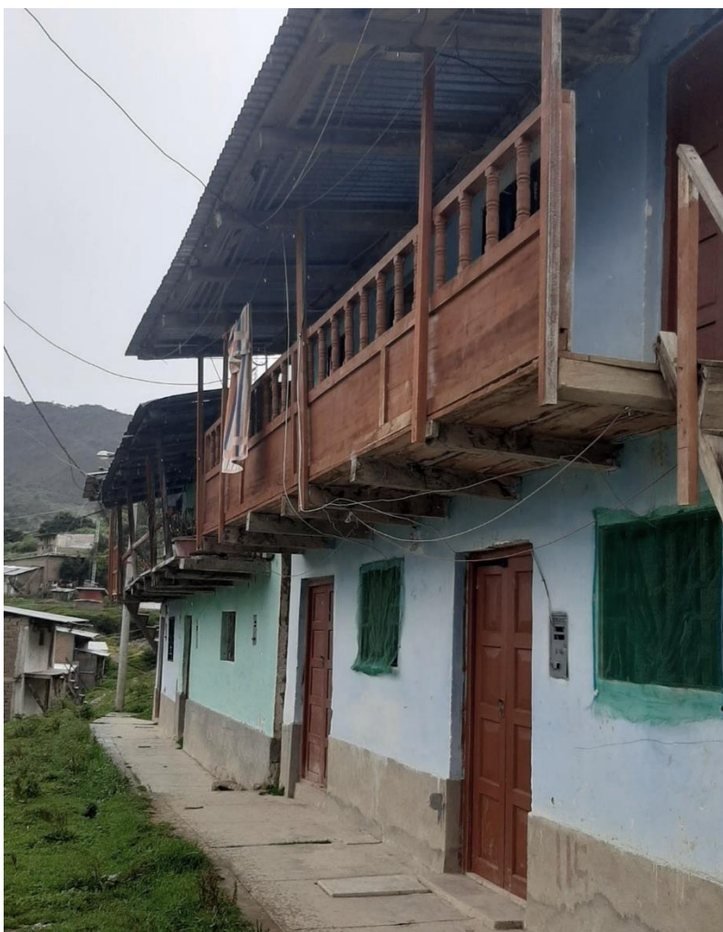
Ilustración 01: Distintos tipos de materialidad y técnicas constructivas. Distrito de Incahuasi - Fuente propia.
