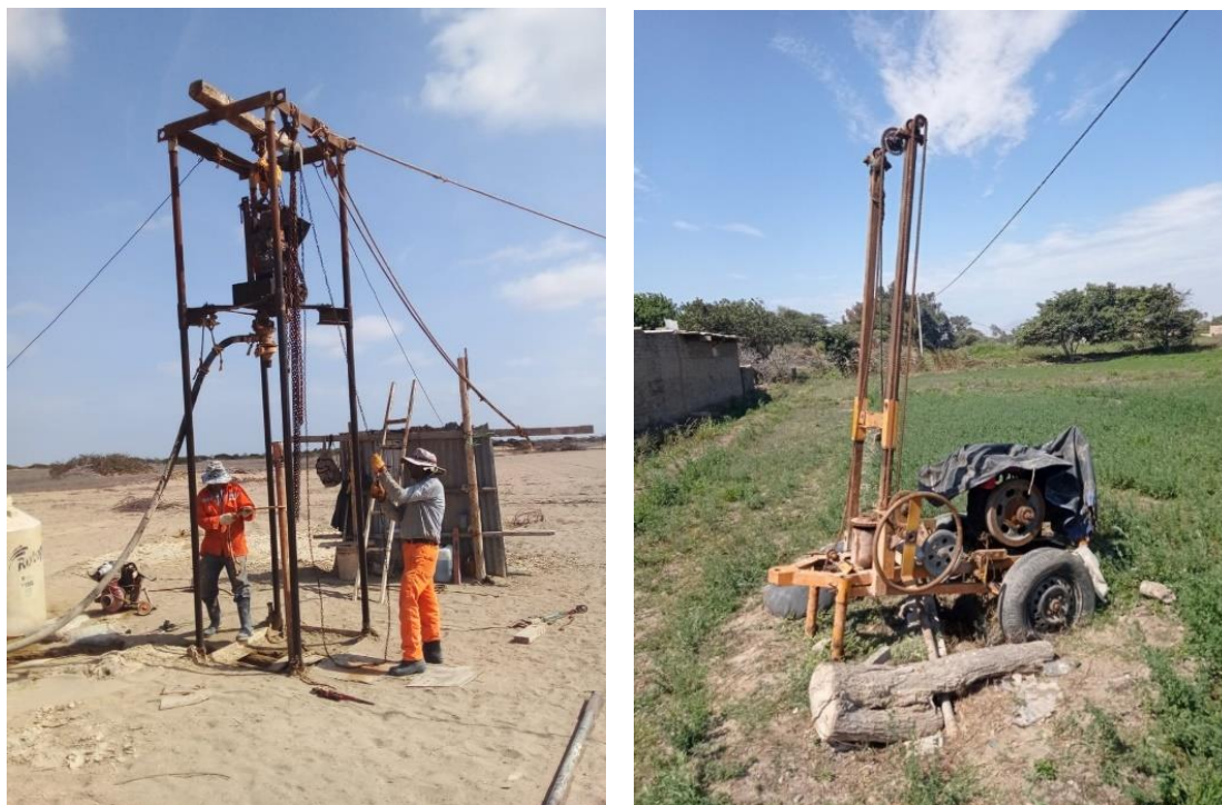
Figura 16 Perforadora A y perforadora B. Propio.
