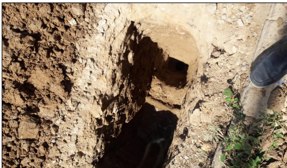
Imagen N° 6 – Excavación de calicata N° 3 en terreno de estudio realizada el 23/02/18
