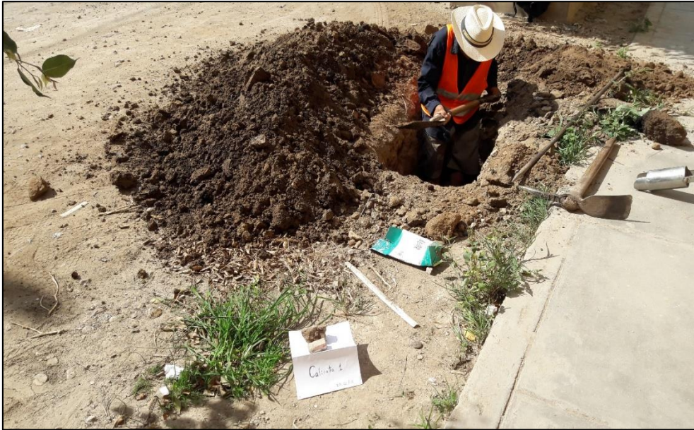
Imagen N° 1 – Excavación de calicata N° 1 en terreno de estudio realizada el 22/02/18
