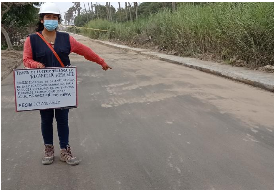
Foto 95. Fin de la obra Fuente: Propia
