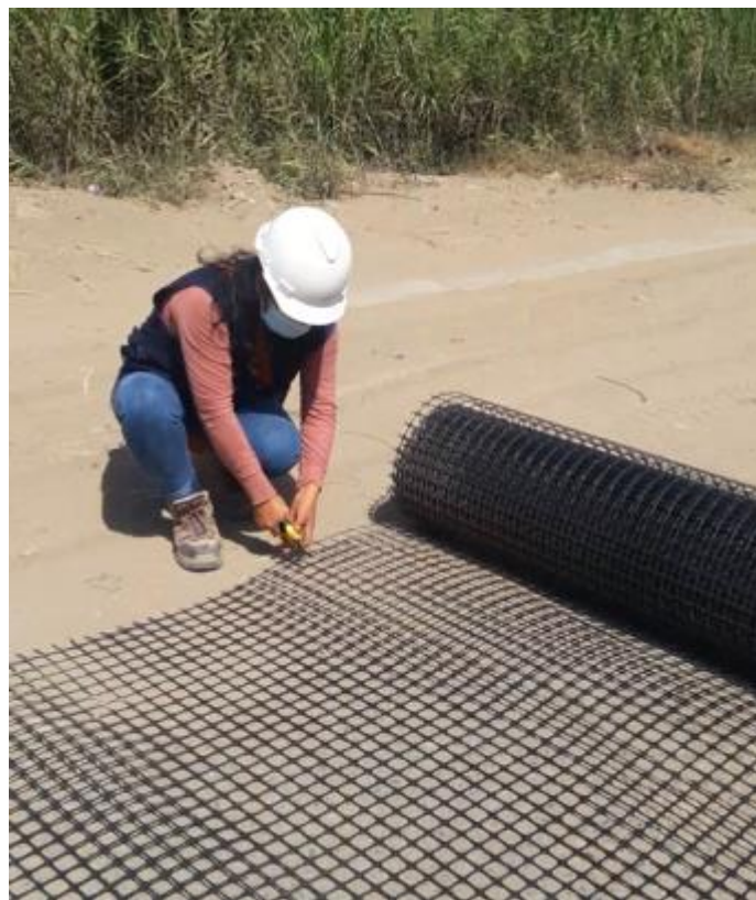
Foto 47. Corte de geomalla biaxial extruida Fuente: Propia
