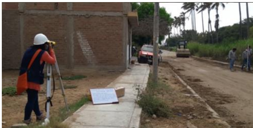
Foto 76. Colocación al extremo izquierdo de la vía Fuente: Propia
