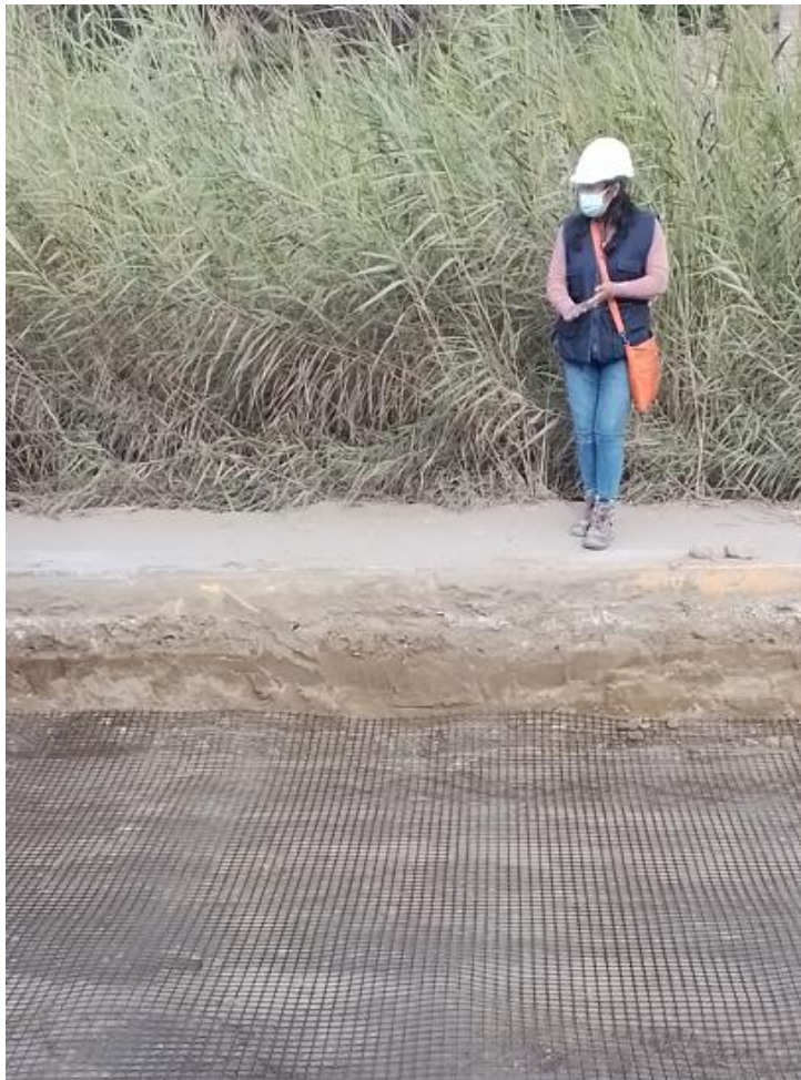
Foto 55. Geomalla biaxial in situ Fuente: Propia
