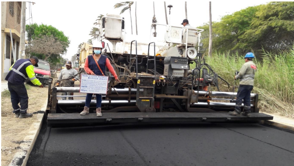
Foto 91. Esparcido del asfalto Fuente: Propia
