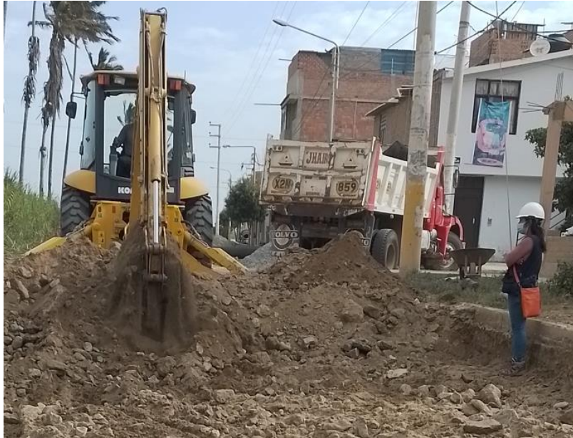
Foto 42. Eliminación de Material del pavimento antiguo de la parte final Fuente: Propia
