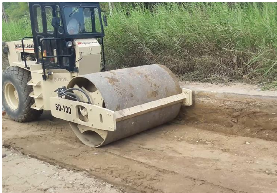
Foto 51. Compactación con rodillo liso Fuente: Propia
