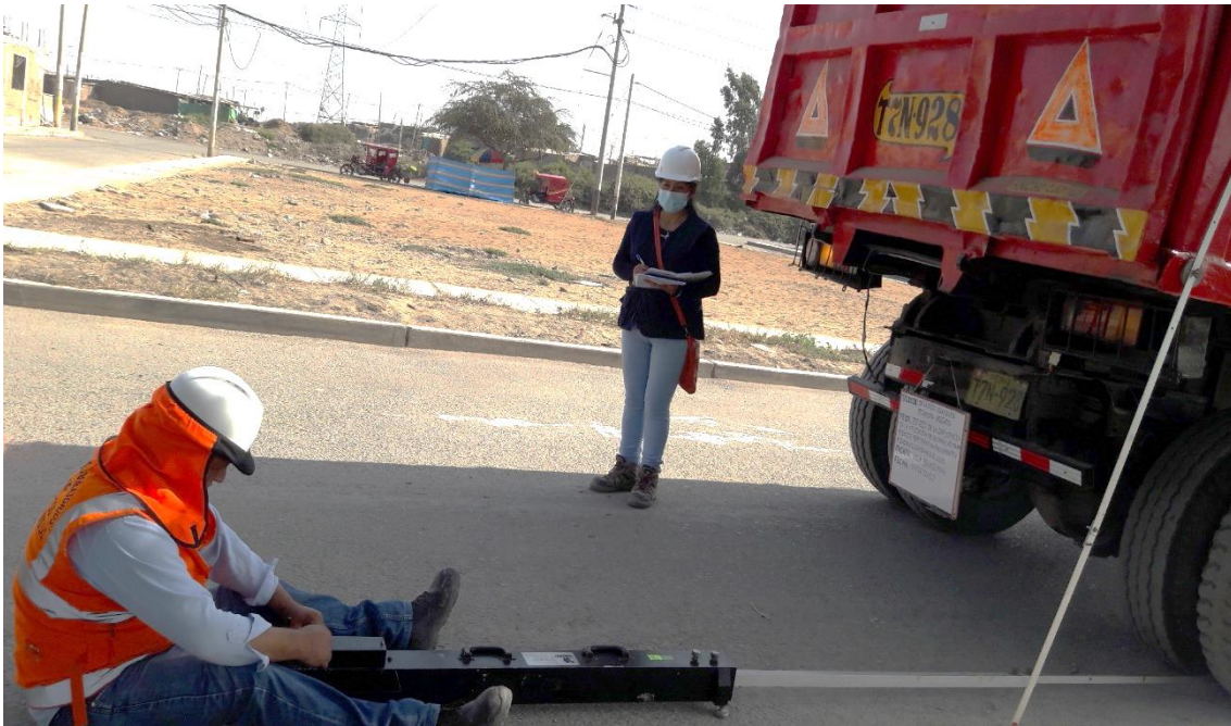
Foto 102. Toma de valores del pavimento antiguo lado izquierdo Fuente: Propia
