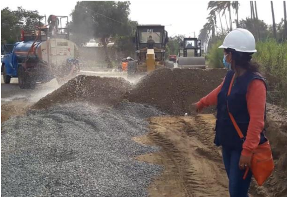
Foto 66. Material de cantera Hitos humedecido Fuente: Propia
