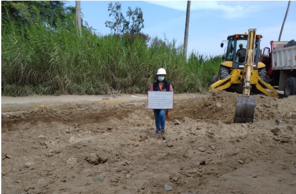
Foto 40. Remoción de pavimento existente
