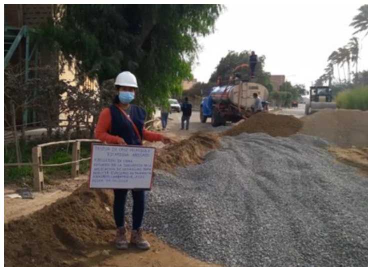
Foto 65. Piedra de \frac{1}{2} de cantera Tres Tomas más el material de subbase de cantera Hitos
