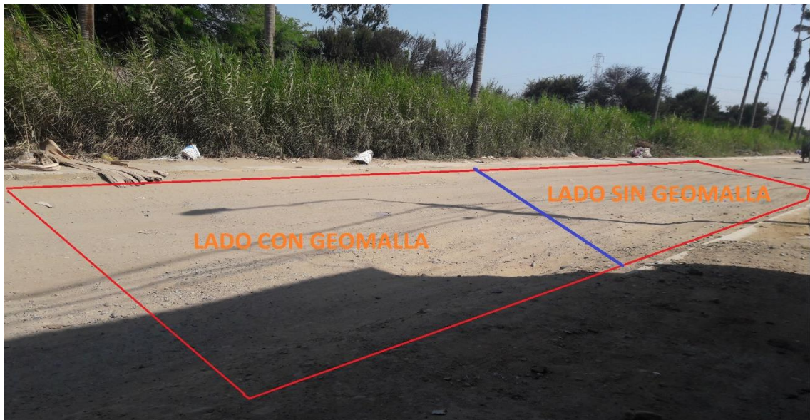
Foto 34. Tramo por ejecutar Fuente: Propia
