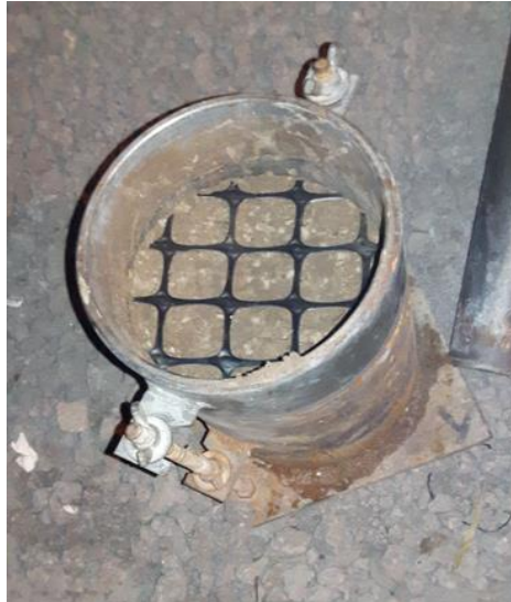
Foto 25. Colocación de la geomalla biaxial BX3030 en la subrasante Fuente: Propia
