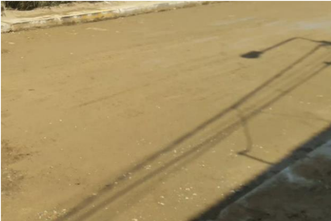
Foto 80. Base granular lista Fuente: Propia
