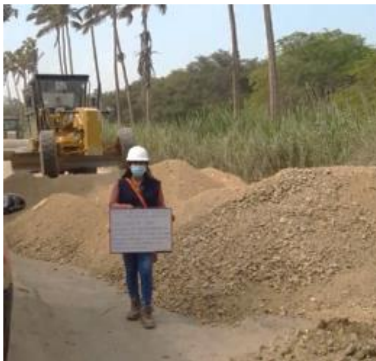
Foto 45. Material para subbase traído de la cantera Hitos Fuente: Propia
