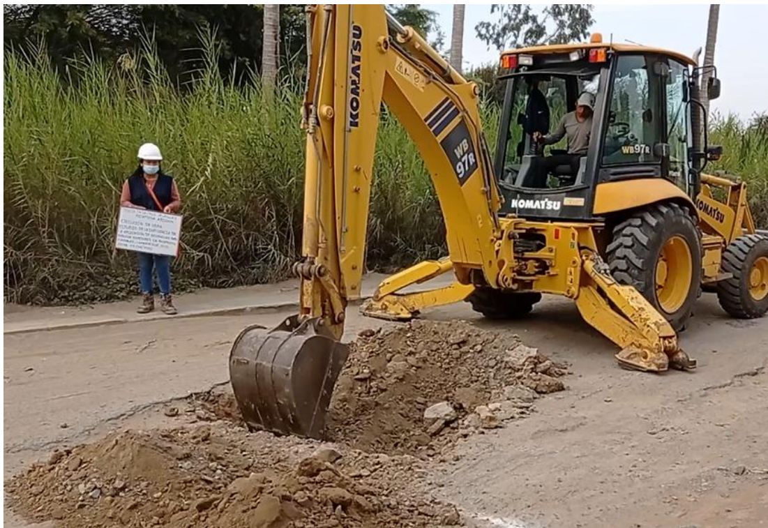
Foto 39. Empieza la excavación Fuente: Propia
