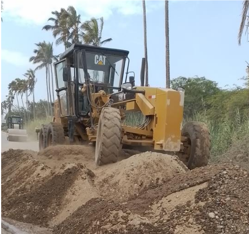
Foto 46. Motoniveladora uniformiza el material buscando la humedad óptima Fuente: Propia
