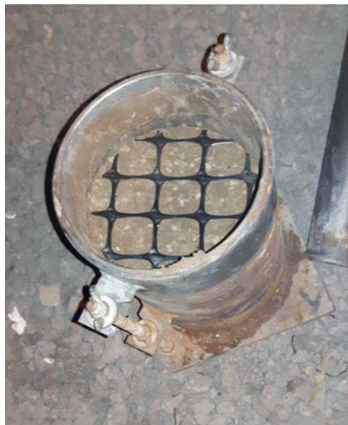
Foto 20. Colocación de la geomalla Fuente: Propia
