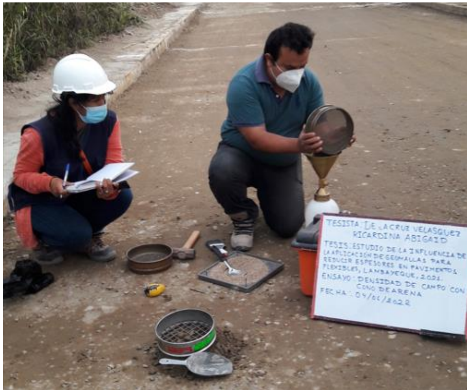
Foto 83. Ensayo Densidad de Campo Fuente: Propia
