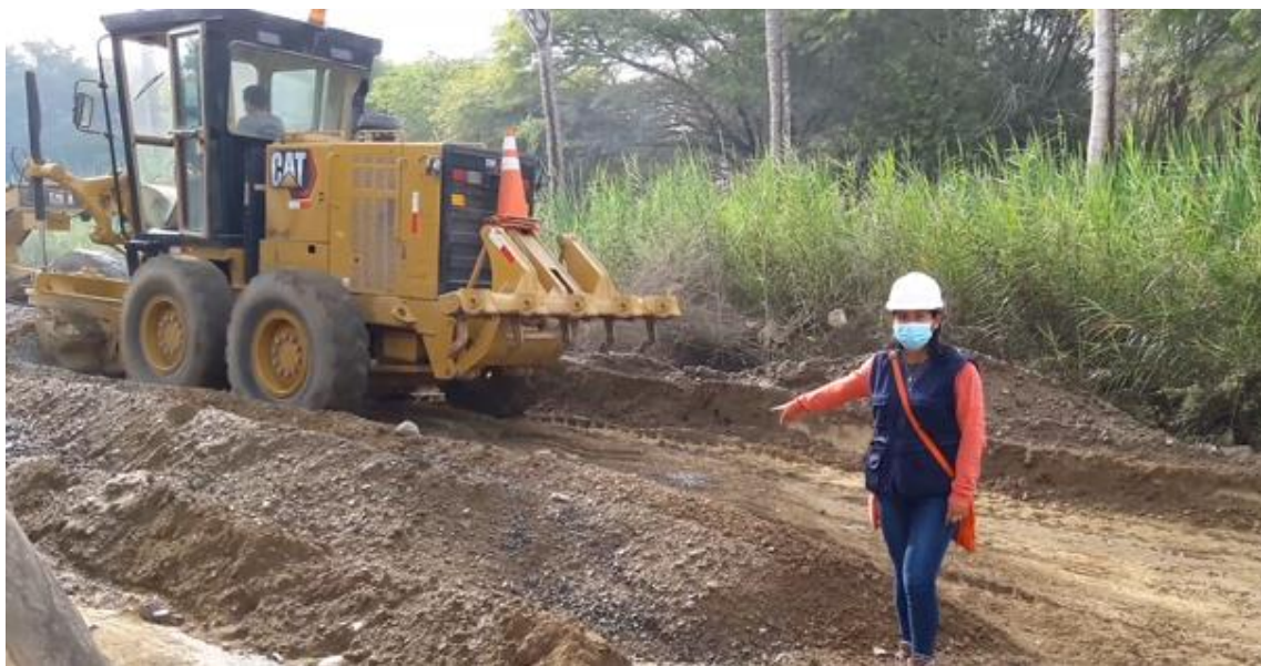
Foto 67. Obtención del material para base granular Fuente: Propia
