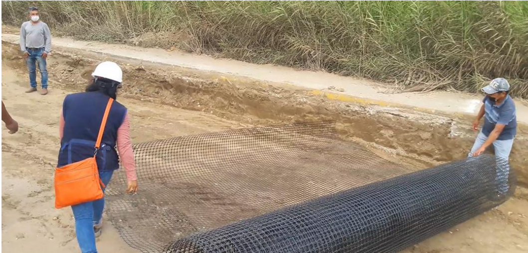
Foto 52. Colocación de la geomalla biaxial en la subrasante Fuente: Propia
