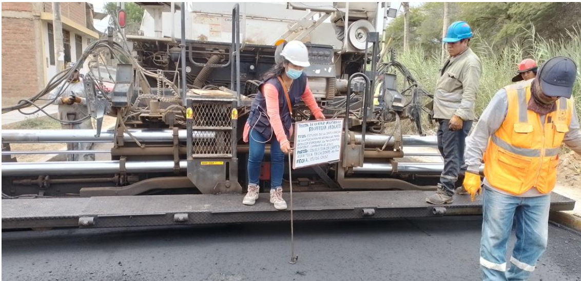
Foto 90. Medida del espesor de la carpeta asfáltica Fuente: Propia
