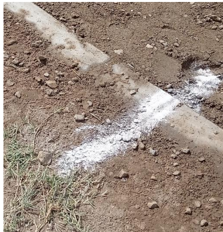
Foto 78. señalización de la plantilla Fuente: Propia
