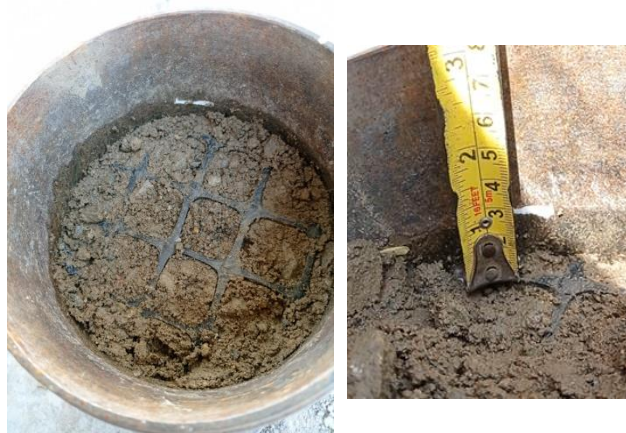
Foto 26. Colocación de la geomalla biaxial BX3030 en la base Fuente: Propia
