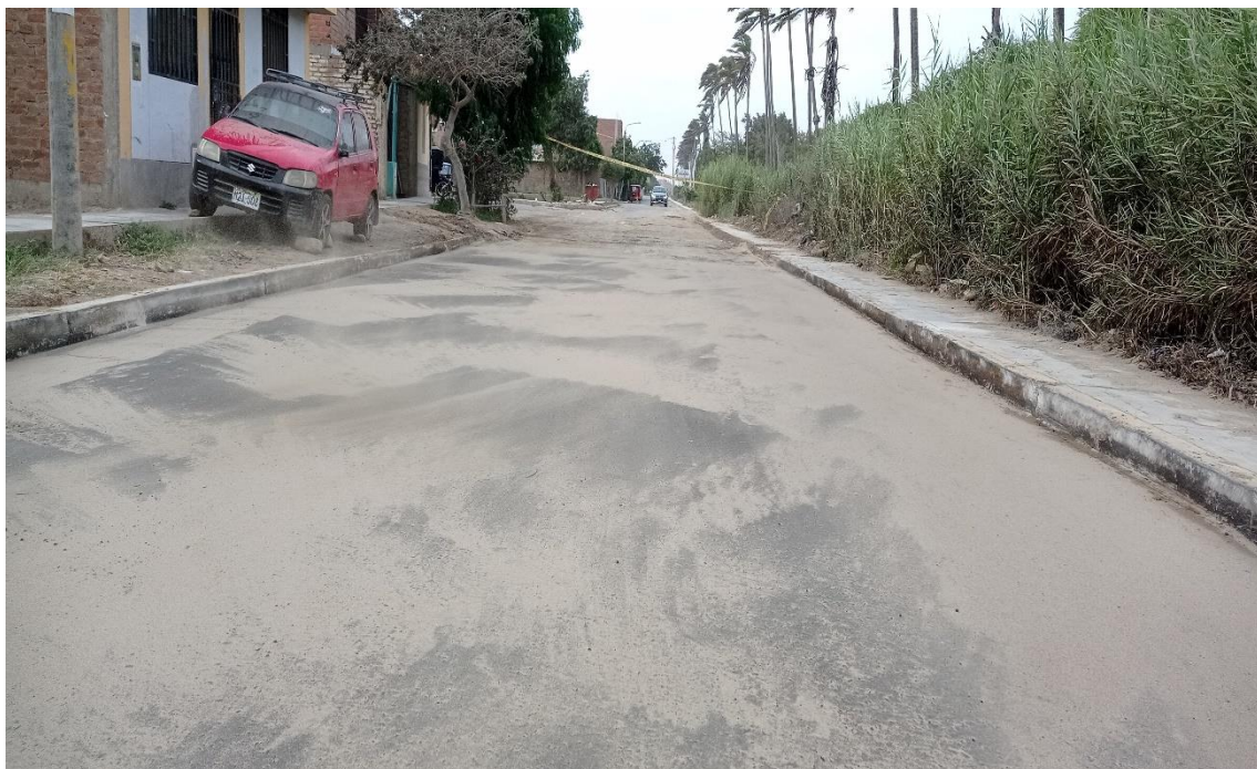
Foto 97. Después de la obra Fuente: Propia
