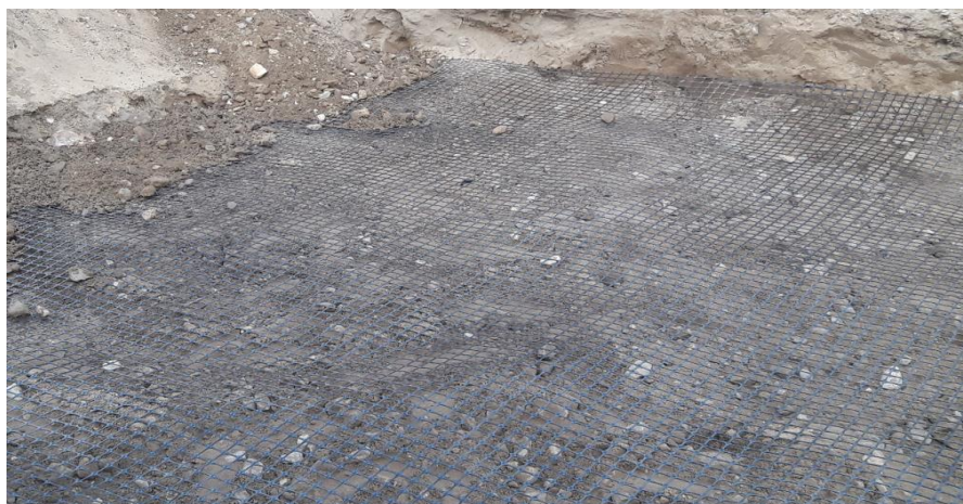
Foto 54. Colocación in situ de la geomalla biaxial Fuente: Propia
