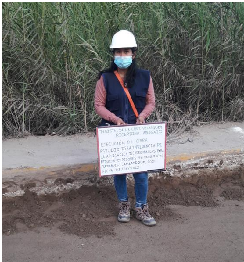
Foto 61. Ejecución del tramo experimental
