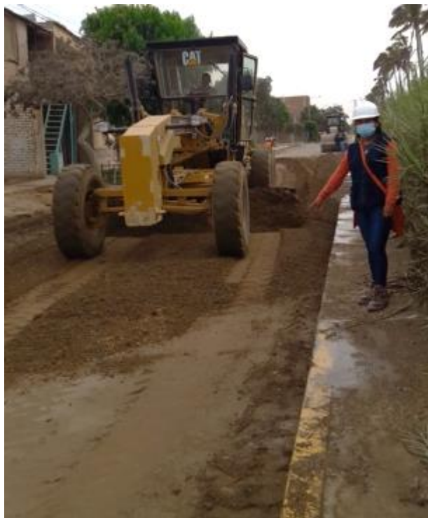
Foto 72. Agregado de base granular esparcido Fuente: Propia
