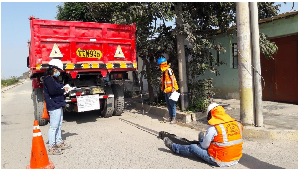
Foto 104. Toma de valores del pavimento antiguo lado izquierdo Fuente: Propia
