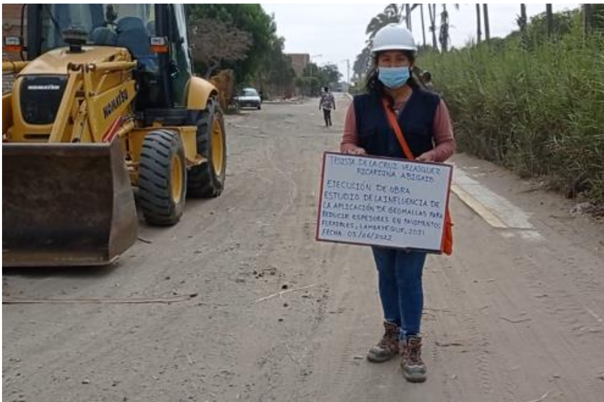
Foto 37. Tramo por ejecutar Fuente: Propia
