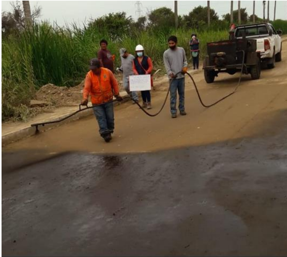
Foto 84. Aplicación de Imprimación asfáltica MC-30 Fuente: Propia
