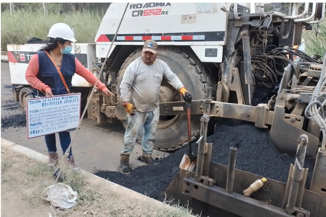
Foto 89. Esparcido manual del asfalto Fuente: Propia
