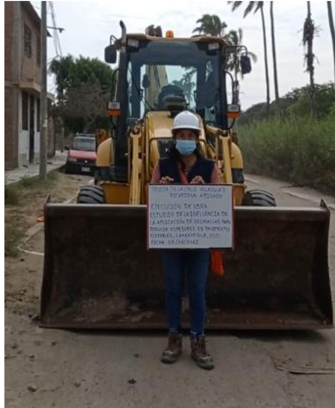
Foto 36. Empieza la excavación Fuente: Propia
