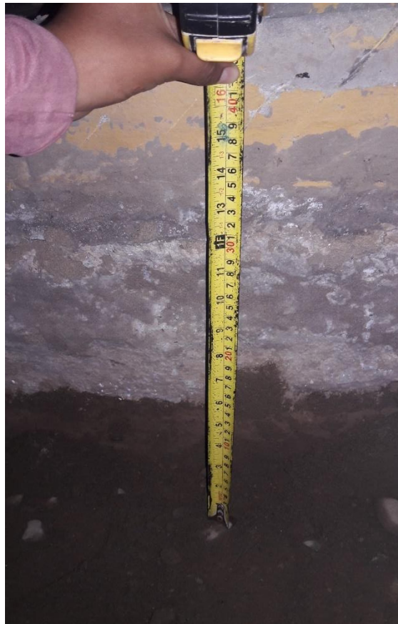
Foto 63. Corroboración de espesor para el pavimento sin geomalla Fuente: Propia
