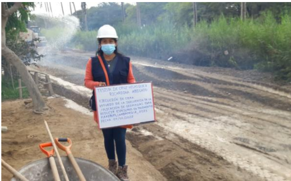
Foto 68. Material para base granular listo para ser esparcido Fuente: Propia
