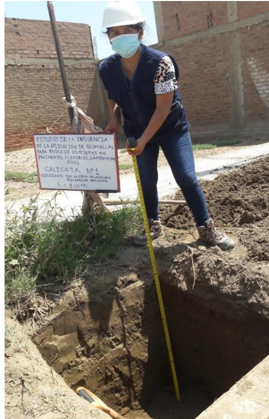
Foto 5. Calicata de donde se extrajo la muestra para subrasante Fuente: Propia
