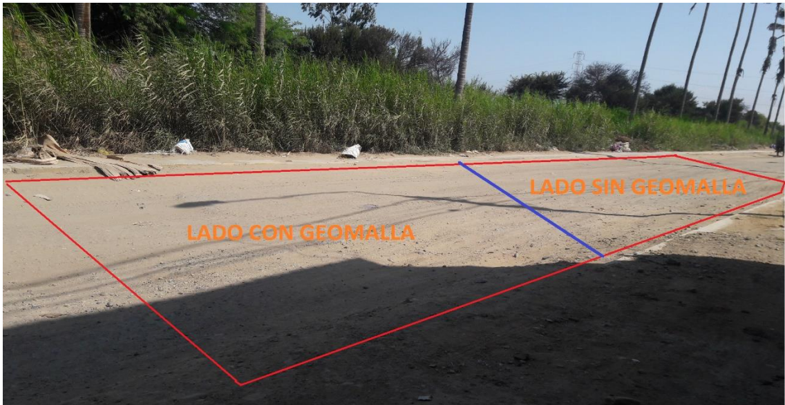
Foto 23. Tramo por ejecutar Fuente: Propia
