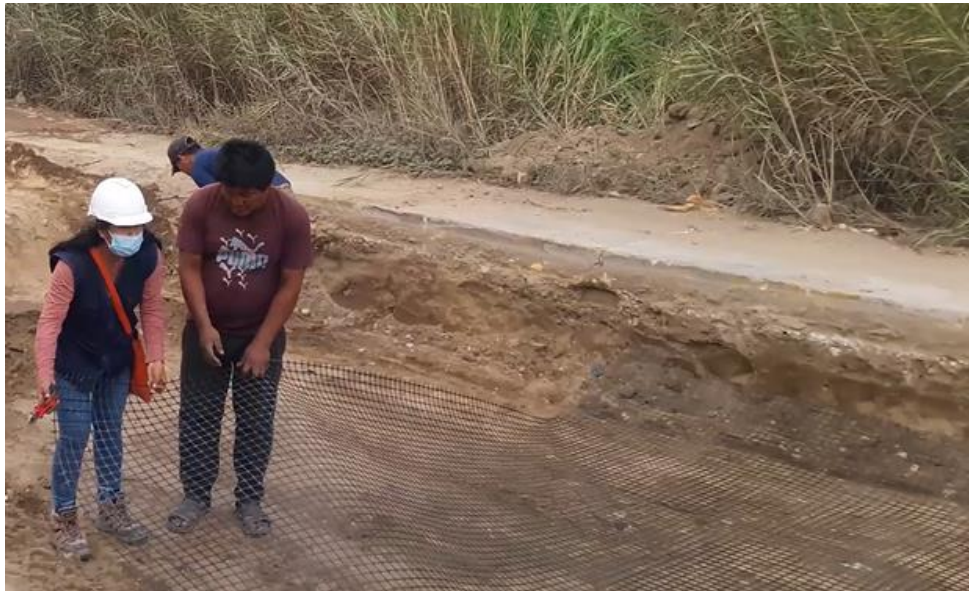
Foto 53. Compactación con rodillo liso Fuente: Propia
