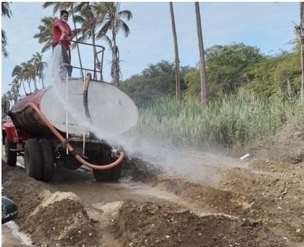
Foto 44. Humedece el material de subbase Fuente: Propia
