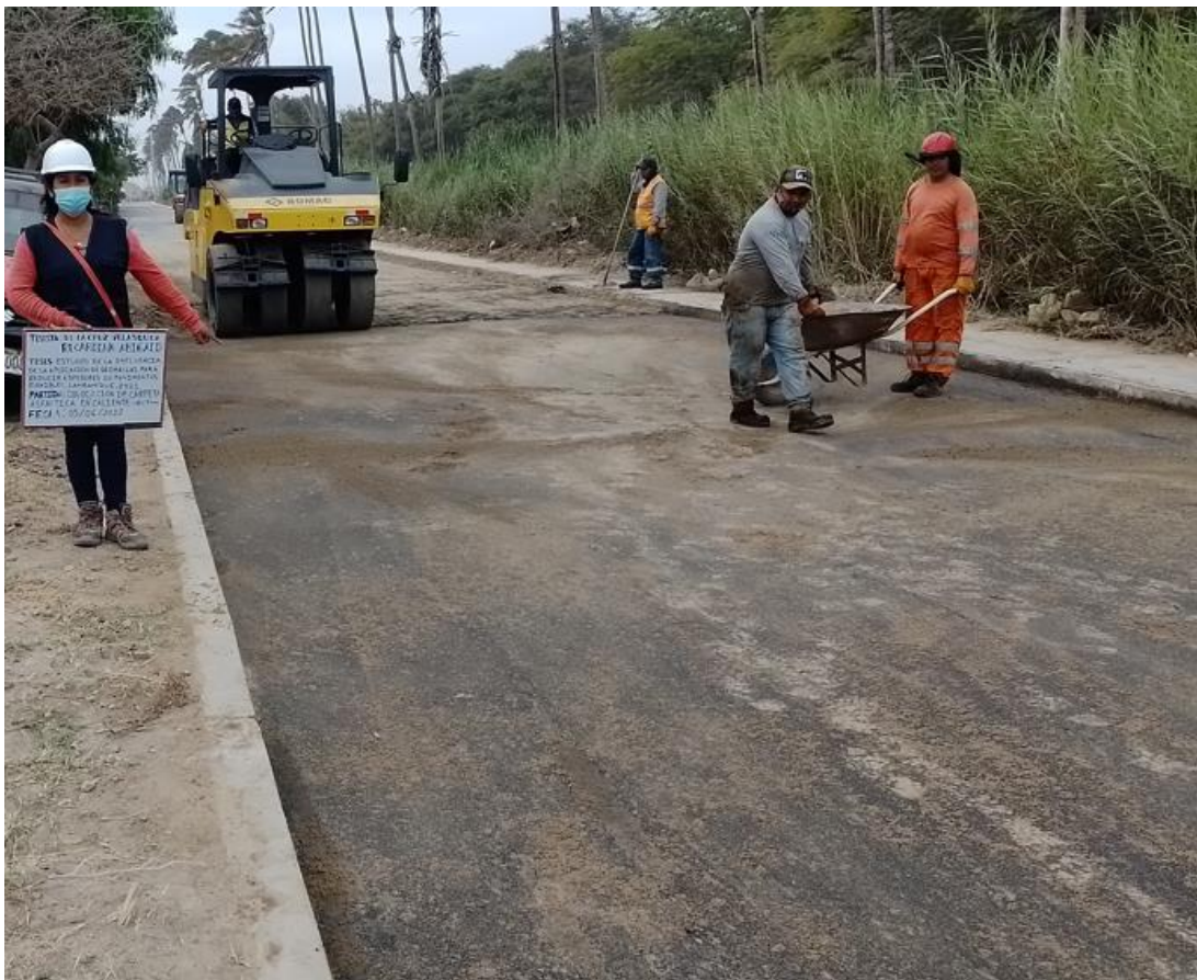
Foto 93. Espolvoramiento de arena Fuente: Propia
