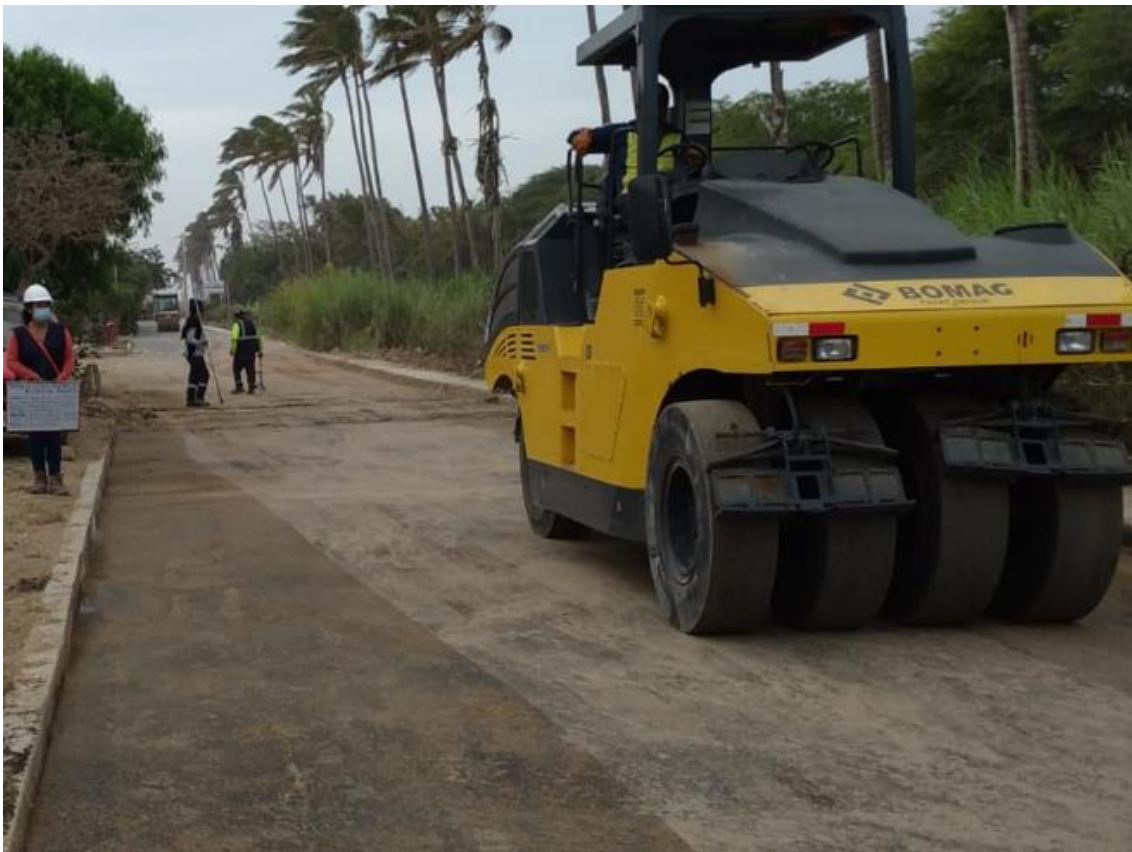
Foto 94. Sellado final con el rodillo neumático Fuente: Propia
