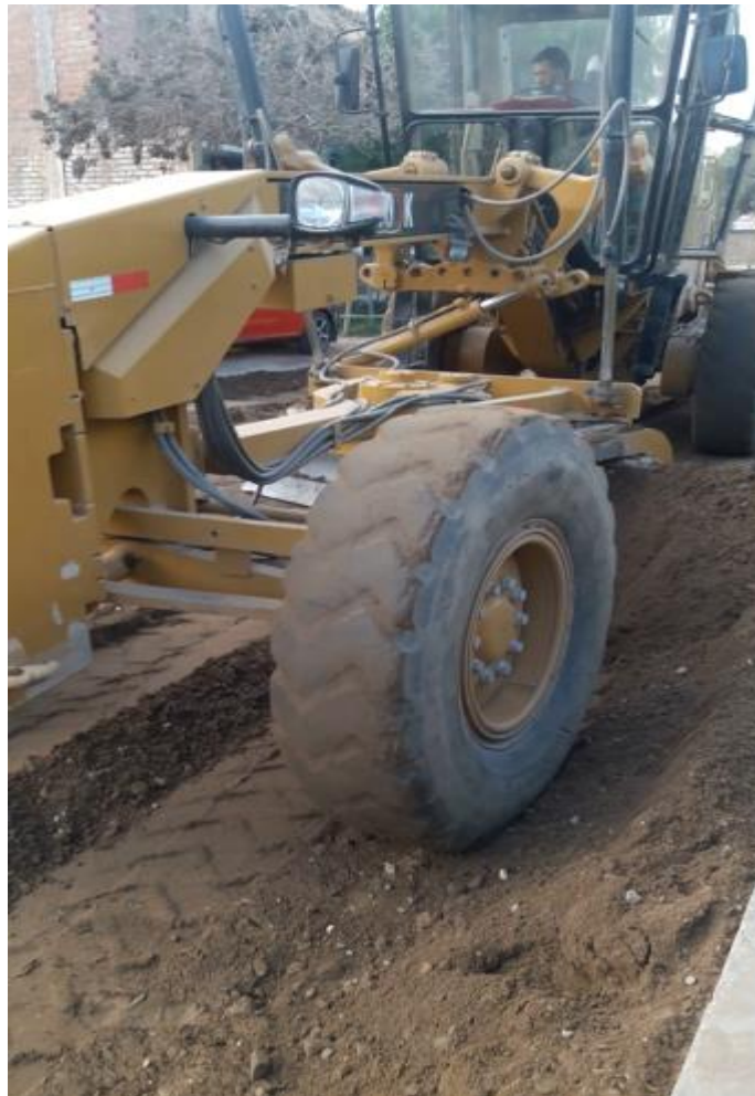
Foto 58. Motoniveladora compacta la subbase Fuente: Propia
