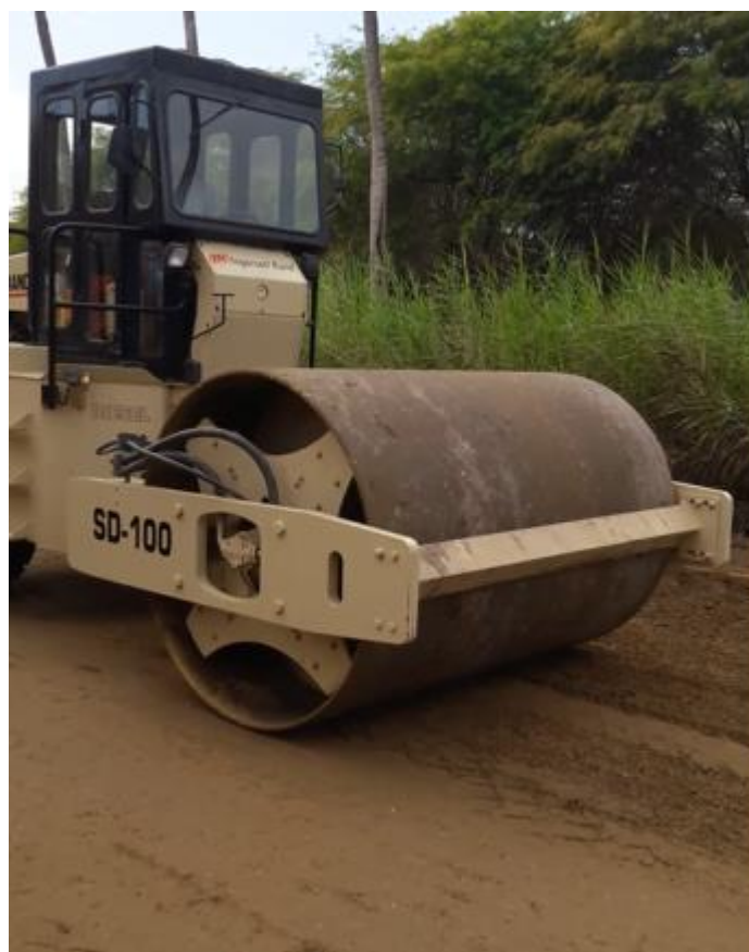
Foto 73. Compactación con rodillo liso Fuente: Propia
