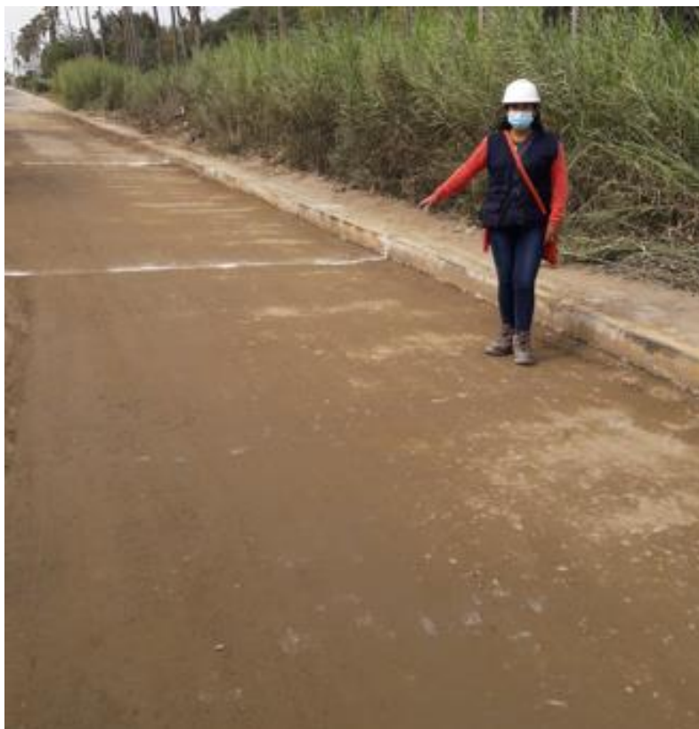
Foto 81. Base granular terminada Fuente: Propia
