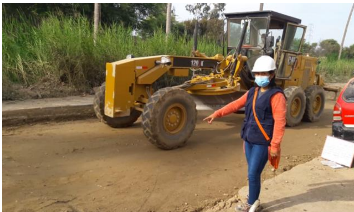
Foto 69. Subbase lista para colocar la base granular Fuente: Propia
