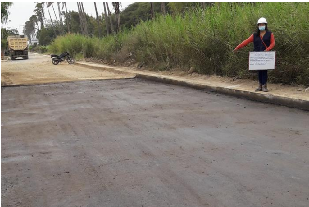
Foto 85. Tiempo de reposo para que seque la imprimación Fuente: Propia
