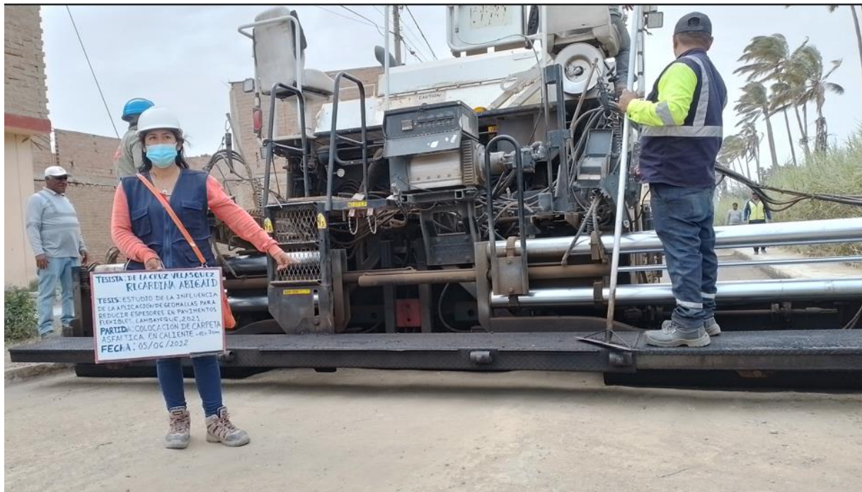
Foto 87. Inicio de la colocación de la carpeta asfáltica Fuente: Propia
