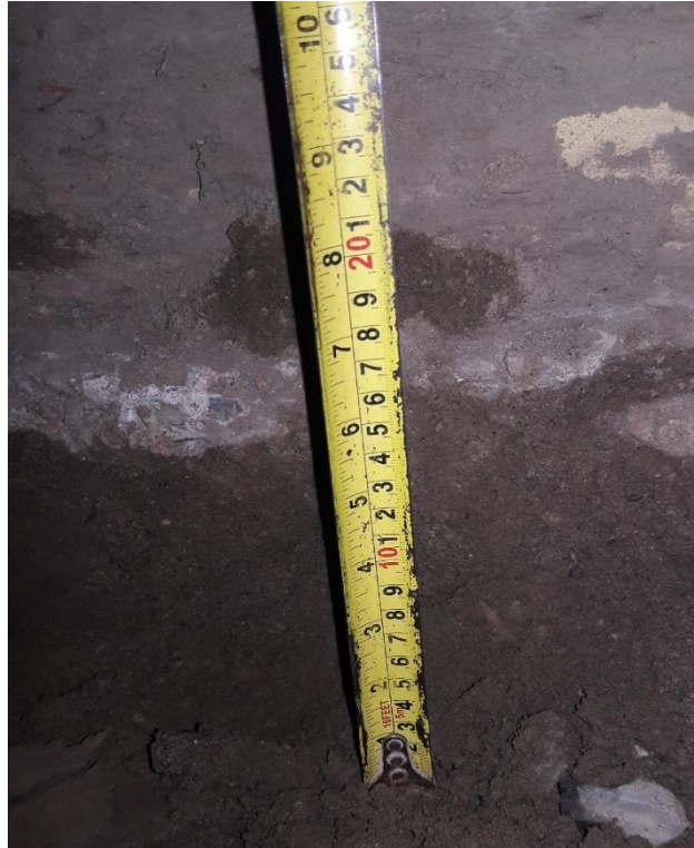
Foto 62. Corroboración de espesor para el pavimento con geomalla Fuente: Propia
