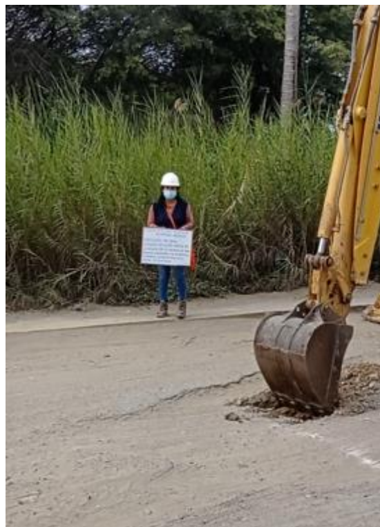
Foto 35. Inicio de obra Fuente: Propia
