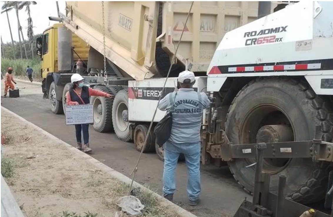
Foto 88. Vaciado del asfalto a la asphaltadora Fuente: Propia
