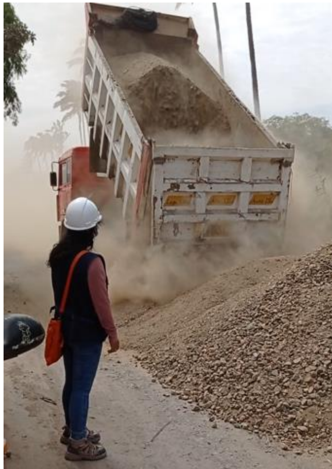
Foto 43. Material para subbase traído de la cantera Hitos Fuente: Propia
