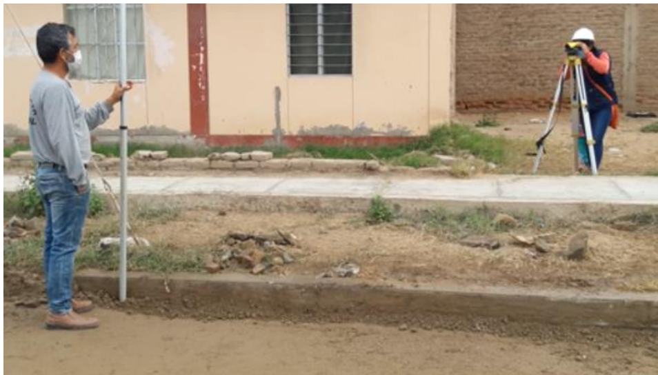
Foto 75. Colocación de plantilla al extremo derecho de la vía Fuente: Propia
