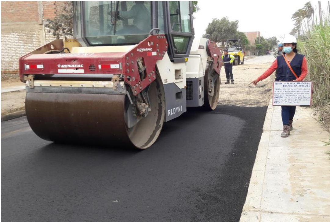
Foto 92. Compactación de carpeta asfáltica Fuente: Propia
