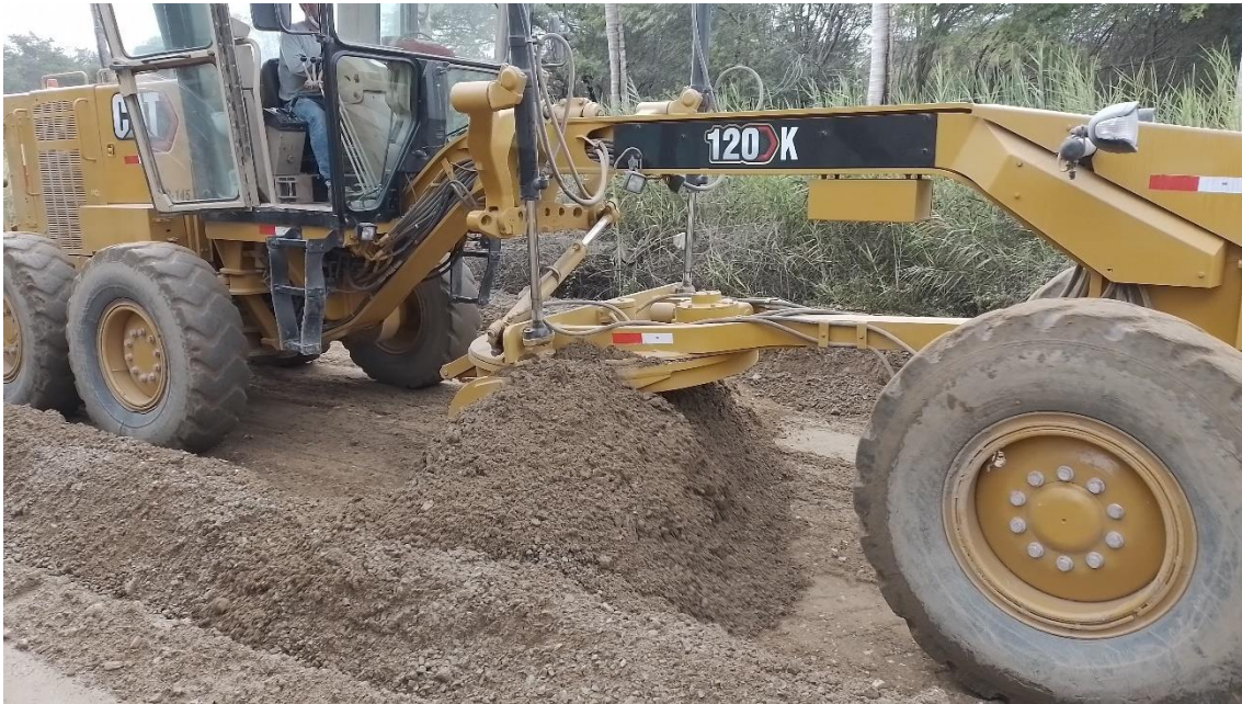
Foto 70. Colocación de la base granular Fuente: Propia
