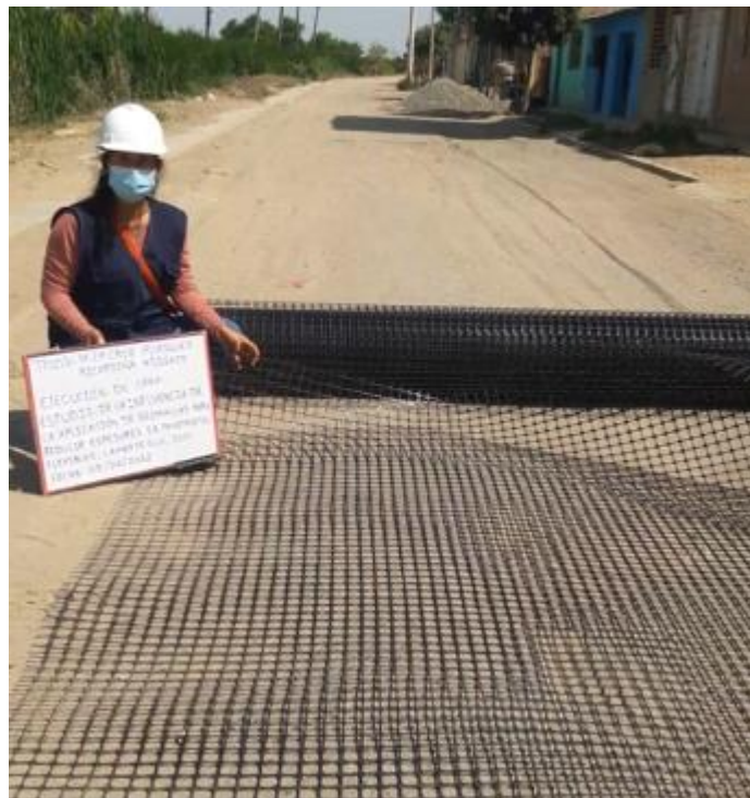
Foto 48. Geomalla biaxial extruida Fuente: Propia
