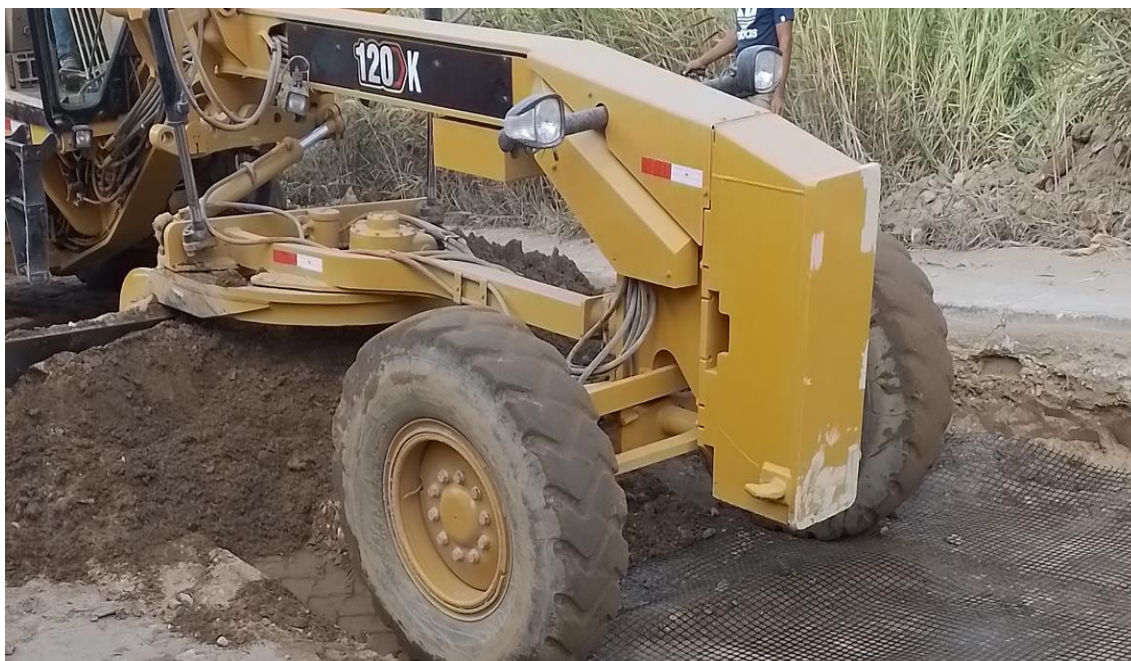
Foto 56. Colocación in situ de la geomalla biaxial Fuente: Propia
