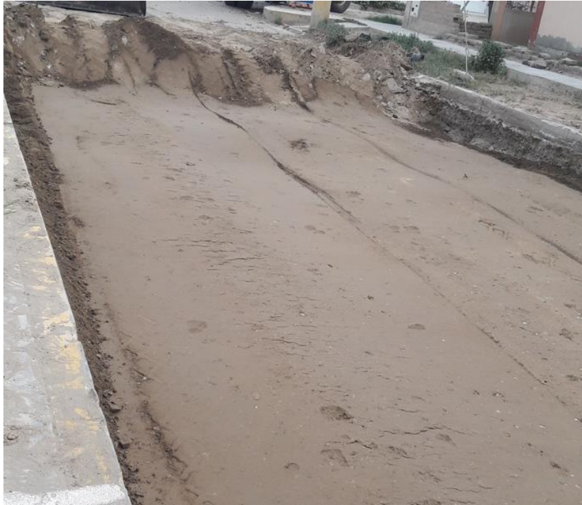
Foto 60. Compactación de los 10m sin geomalla
