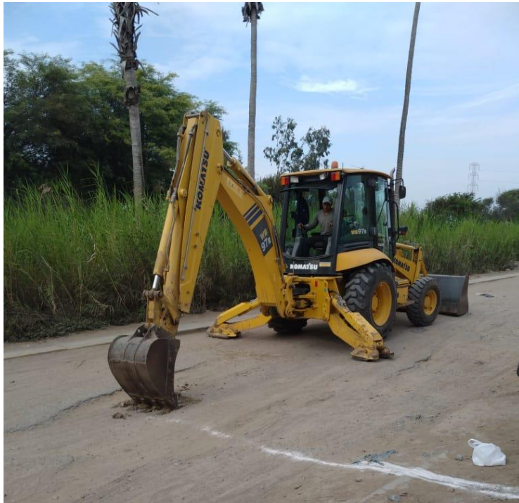
Foto 38. Empieza la excavación Fuente: Propia
