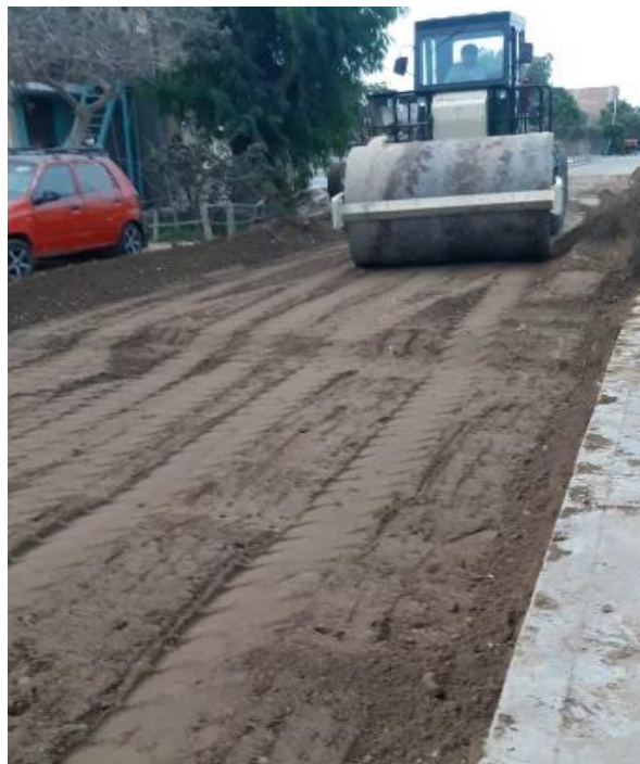
Foto 59. Rodillo liso ingresa a compactar la subrasante Fuente: Propia
