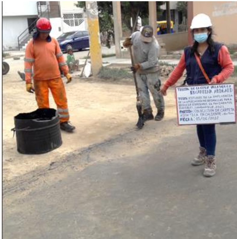
Foto 86. Sellador de la carpeta asfáltica Fuente: Propia
