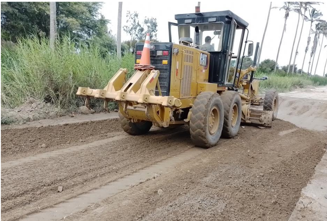
Foto 71. Agregado de base granular esparcido Fuente: Propia
