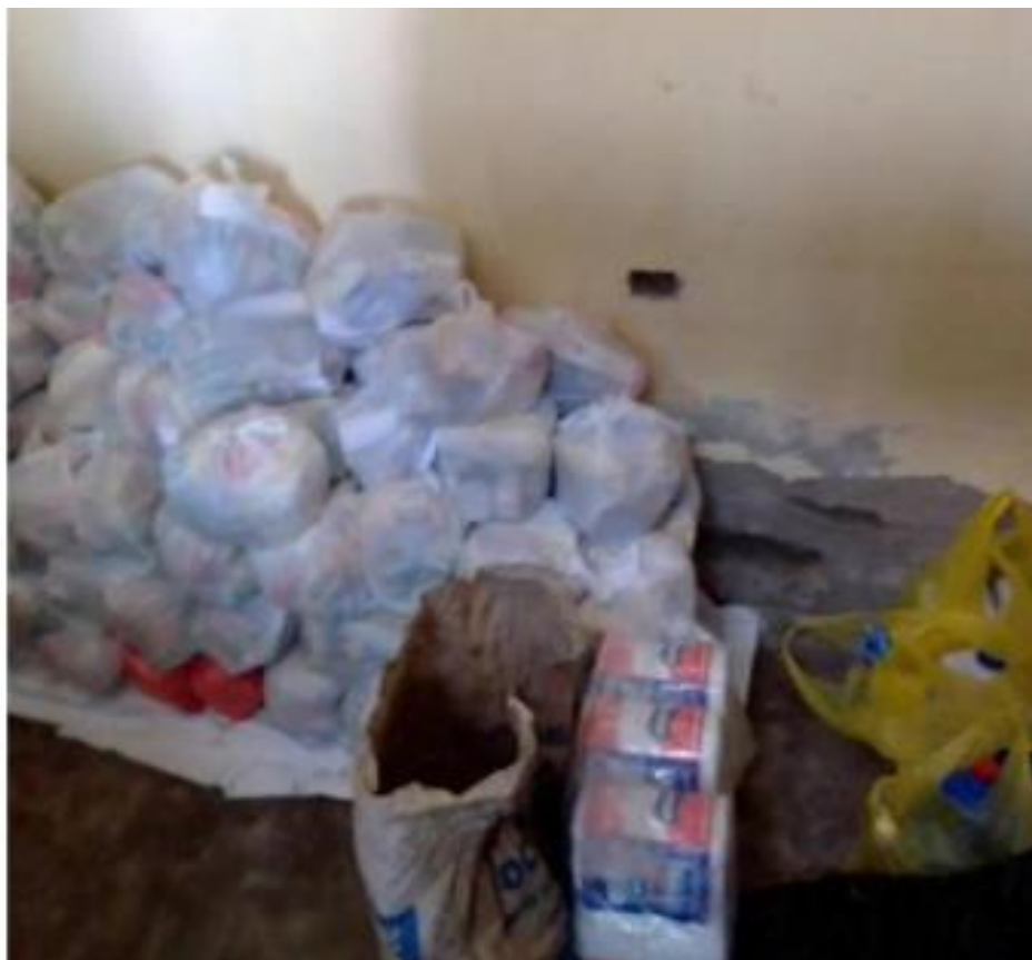
Figura. Presencia de humedad en pared de almacén y productos
