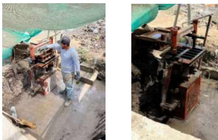
Fig. 21. Elaboración de los adoquines en la mesa vibratoria. Fuente Propia
