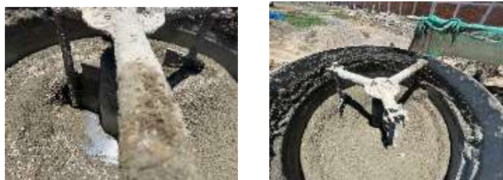
Fig. 20. Mezcla de concreto para la fabricación de los adoquines. Fuente Propia
