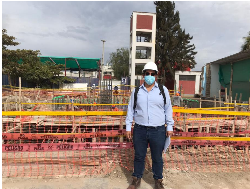
Imagen 83: Visita a obra
