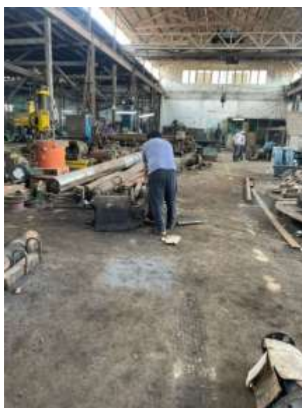
Figura 19. Piso deteriorado y piezas desordenadas
