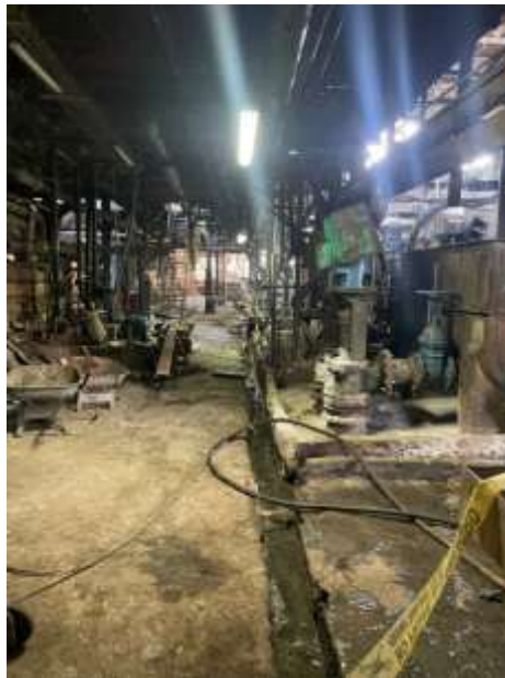
Figura 6. Primer nivel de planta, piso desnivelado y deteriorado
