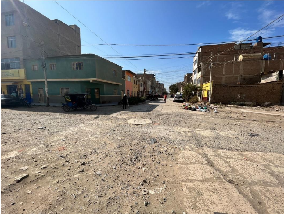
Figura 33. Levantamiento de la calle Húsares de Junín.
