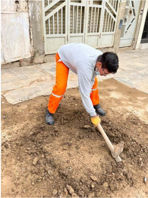
Figura 23. Calicata N°5 Calle Ayacucho. Iniciando la calicata.
