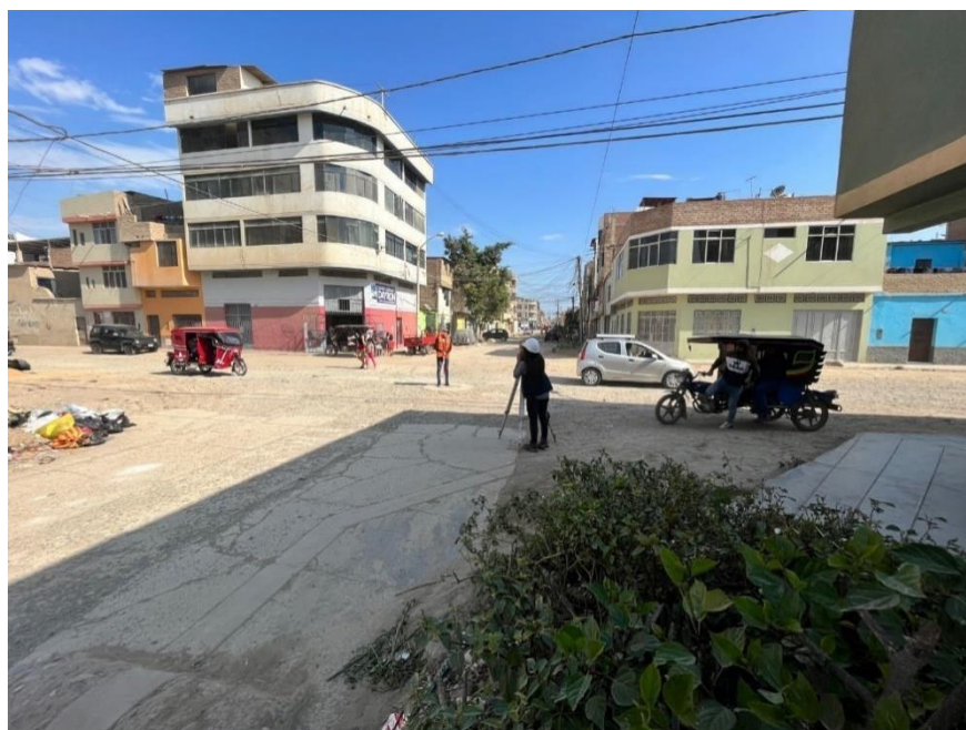
Figura 36. Levantamiento de la calle Húsares de Junín.
