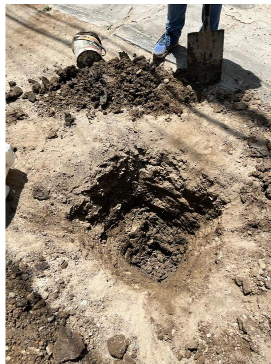
Figura 22. Calicata N°4 Calle Húsares de Junín. Término de la segunda capa.
