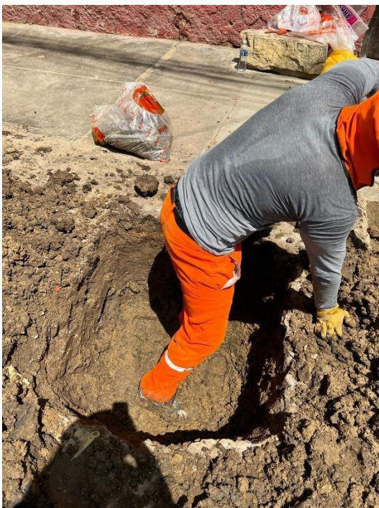
Figura 21. Calicata N°3 Calle Huáscar. Término de la primera capa.
