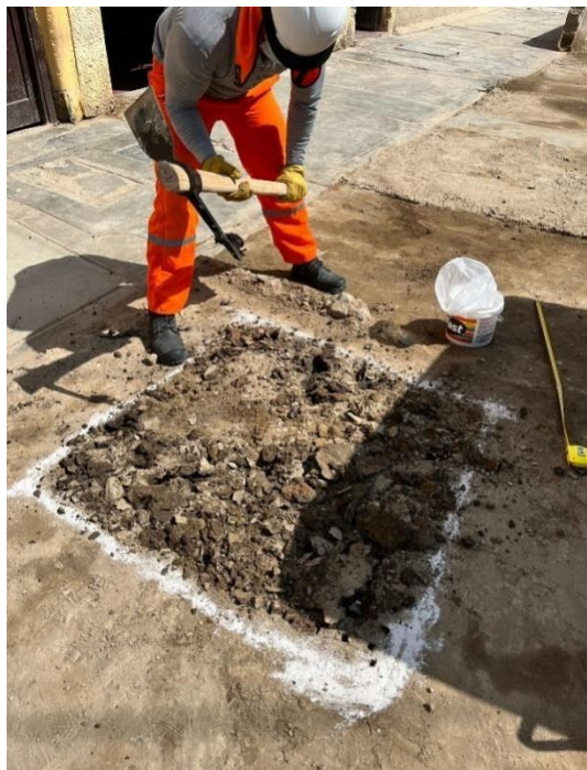
Figura 20. Calicata N°2 Calle Atahualpa. Iniciación de la primera capa.
