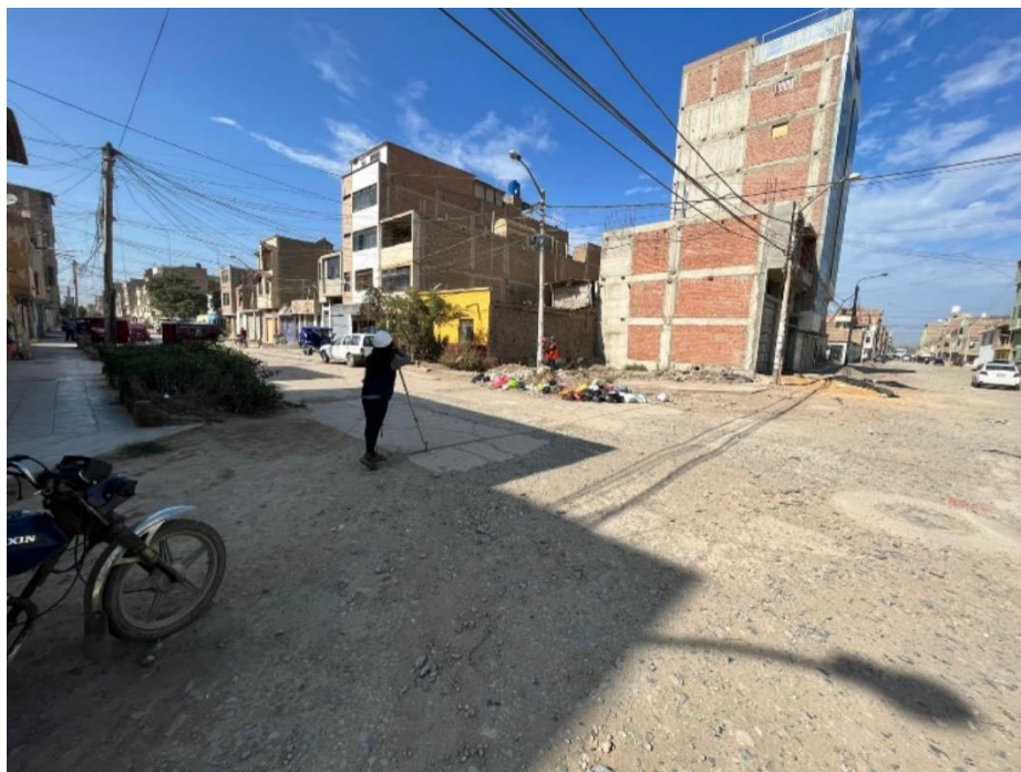
Figura 34. Levantamiento de la calle Húsares de Junín.
