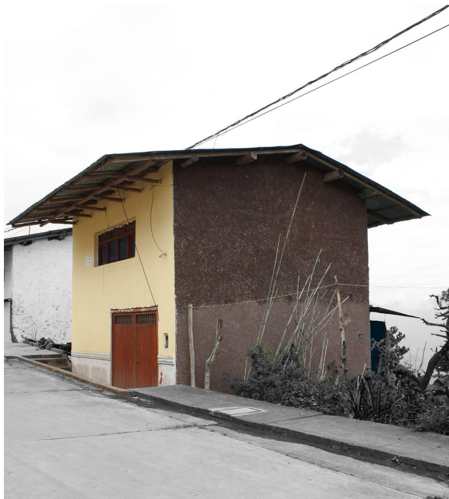
Ilustración 15 / Toma de las cubiertas a dos aguas de las viviendas tradicionales de Kuntur Wasi. Fuente: Elaboración propia.
