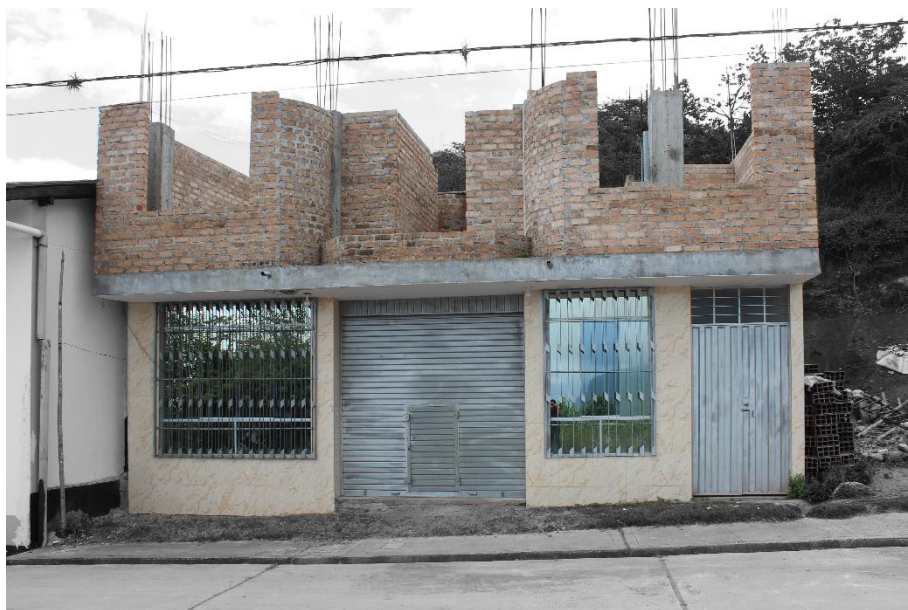
Ilustración 27 / Toma de las viviendas en construcción con materiales industrializados. Fuente: Elaboración propia.
