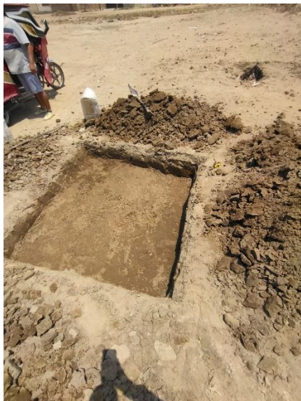
Figura N° 21: Excavación y nivelación del tramo de prueba
