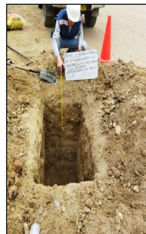
Figura N° 5: Calicata 3. Fuente: Propia
