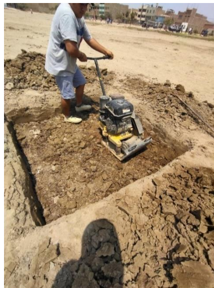
Figura N° 20: Mezclado de adición y compactación
