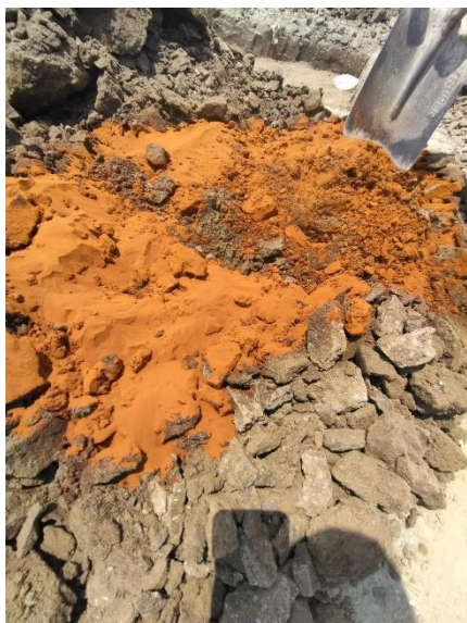
Figura N° 20: Mezclado de adición y compactación
