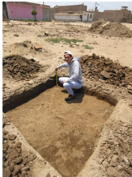
Figura N° 21: Excavación y nivelación del tramo de prueba
