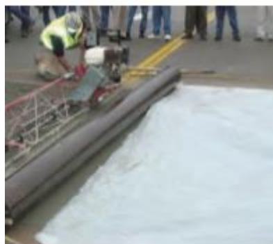
Ilustración 6 Curado en campo de un concreto permeable
