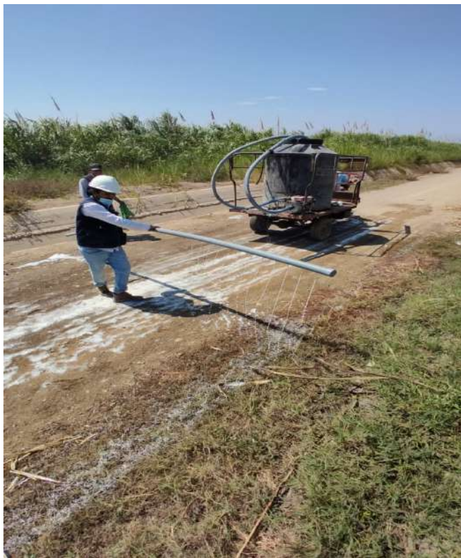
Figura N° 39. Riego de aditivo – tramo de prueba Fuente: Fotografiado propio 2022
