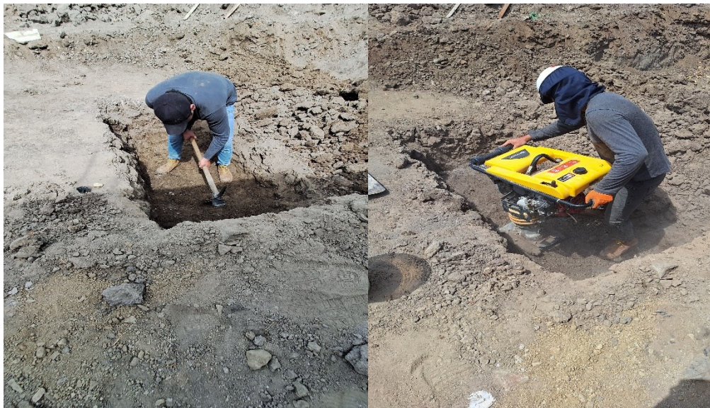
Fig. 32. Nivelación y compactación del tramo de prueba
