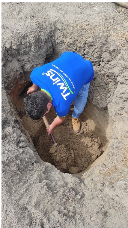
Fig. 8. Excavación calicata 01
