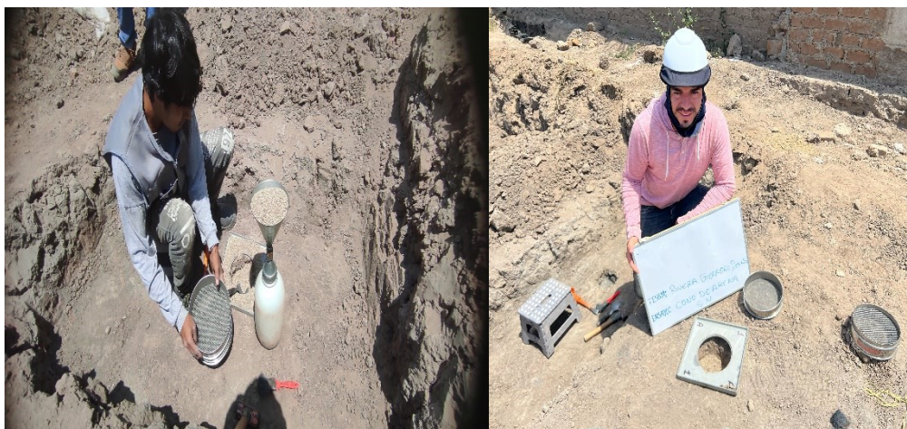
Fig. 33. Densidad de campo del tramo de prueba
