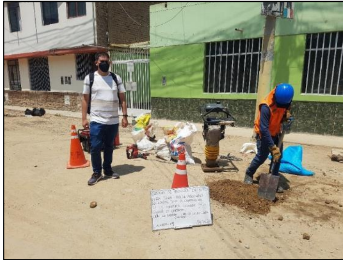
Fotografía 11: Reposición con agregado granular (Calicata N°4)
