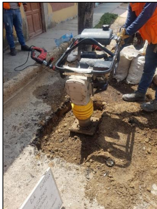
Fotografía 8: Uso de compactador para la reposición del agregado granular.
