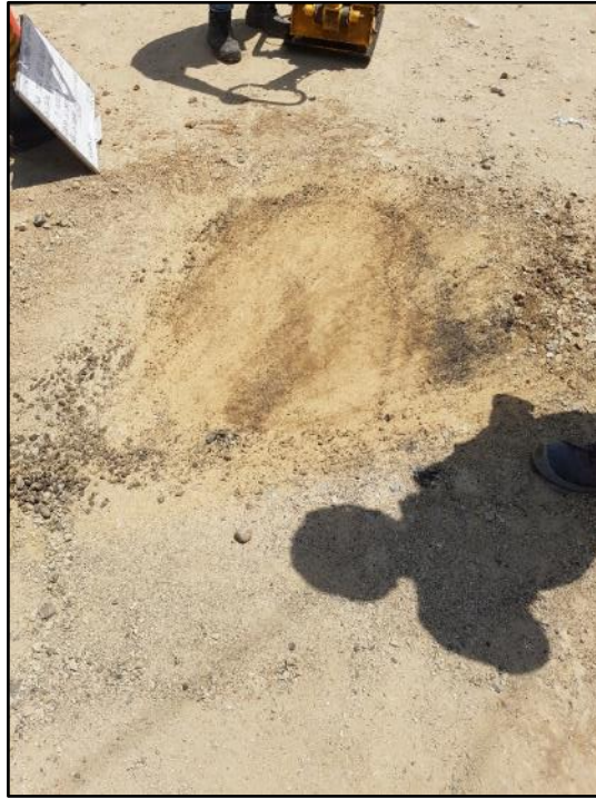
Fotografía 13: Uso de sellante en la carpeta asfáltica
