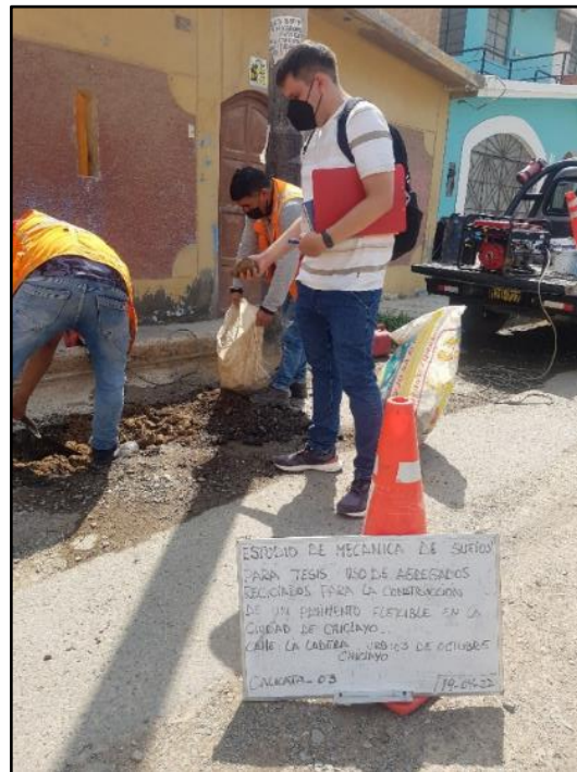
Fotografía 7: Recolección del agregado granular (Calicata N°3)
