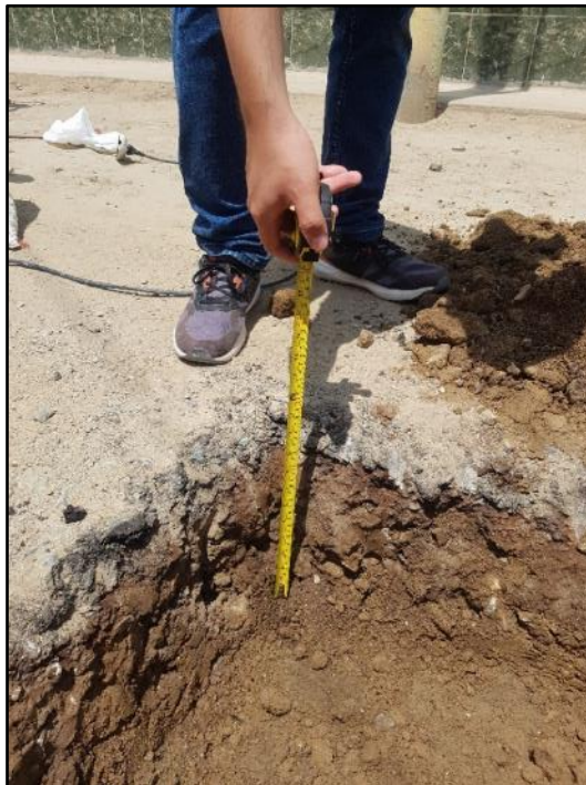
Fotografía 12: Toma de medida hasta la subrasante
