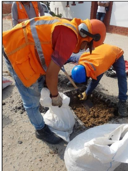
Fotografía 4: Toma de muestras de la base granular.
