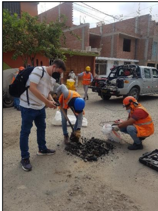
Fotografía 2: Toma de muestras de la carpeta asfáltica.
