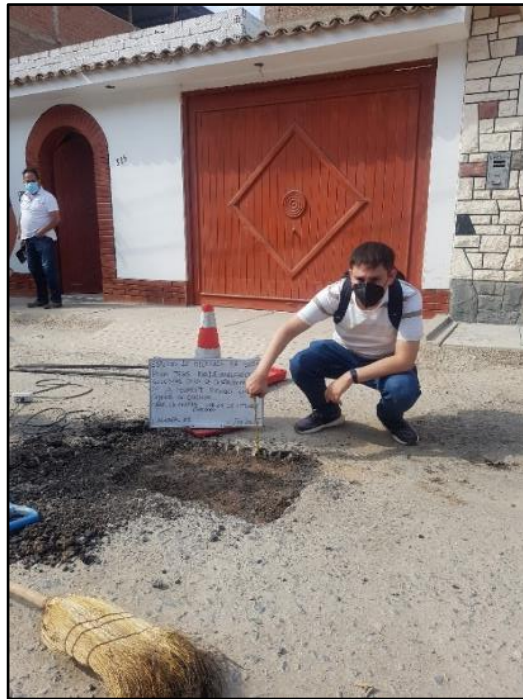
Fotografía 3: Toma de medida del espesor de la carpeta asfáltica.
