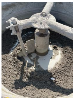
Figura 37: Mezcla de materiales para la elaboración del concreto para adoquines
