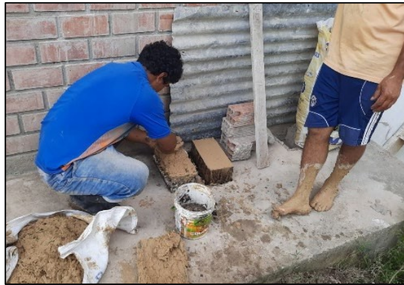
Figura 46: Mezcla puesta al molde para el adobe normal.
