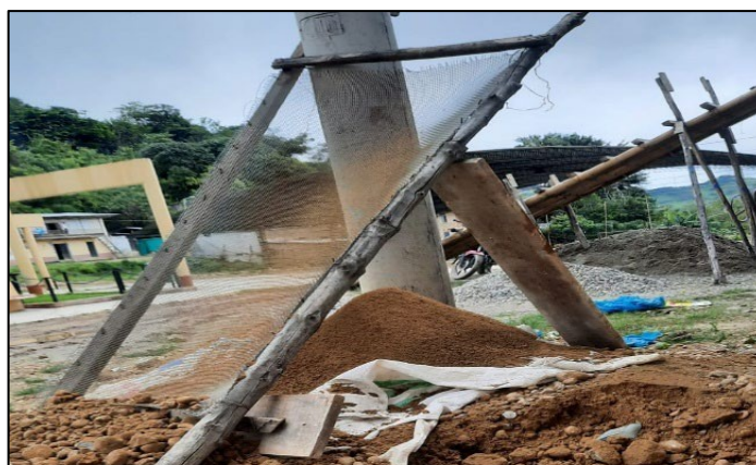
Figura 42: Zarandeado del material para el adobe normal.
