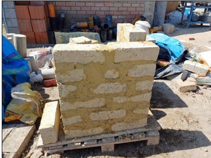
Figura 29: Elaboración de los muros para el ensayo de murete diagonal.
