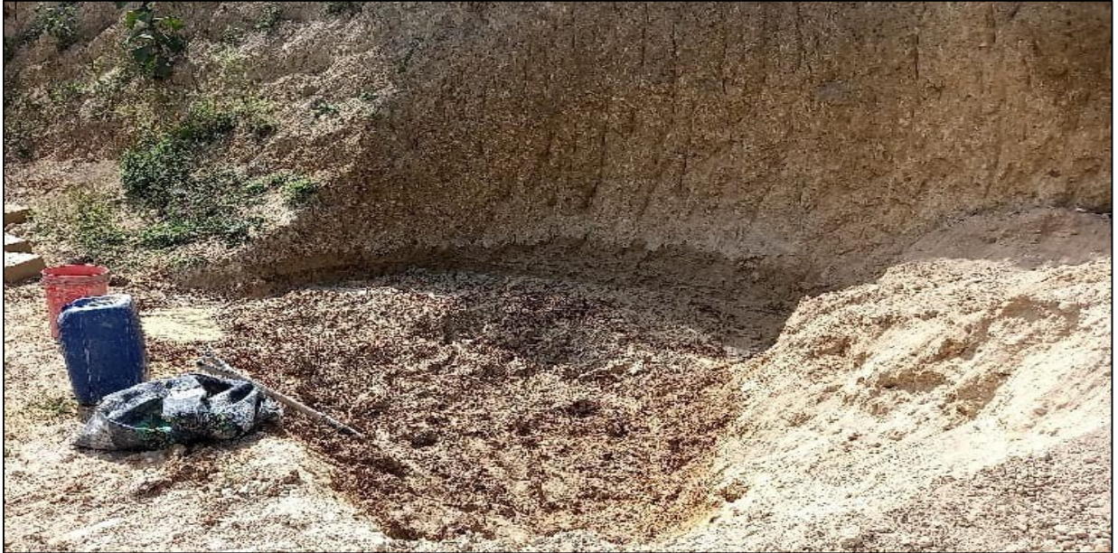
Figura 38: Mezcla para el adobe.
