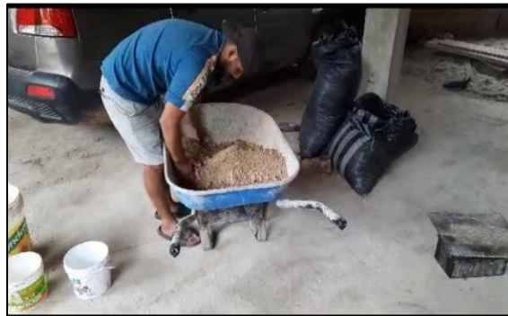
Figura 23: Mezclado de los materiales.
