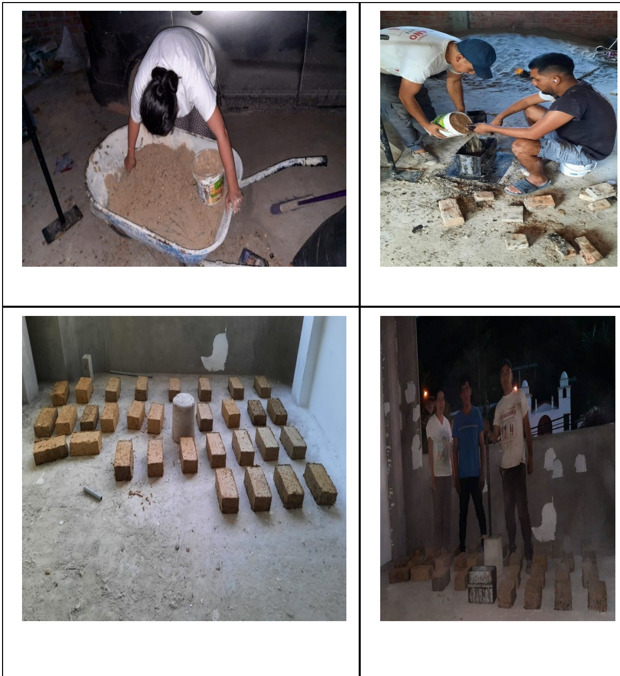
Figura 51: Elaboración de adobe compactado con viruta de madera y pajilla de arroz.
