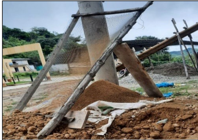
Figura 20: Tamizado de material para elaboración del adobe.
