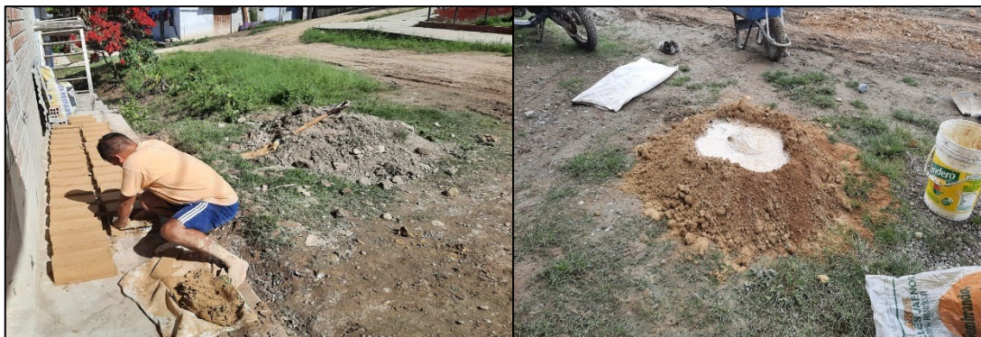
Figura 37: Fabricación del adobe normal.
