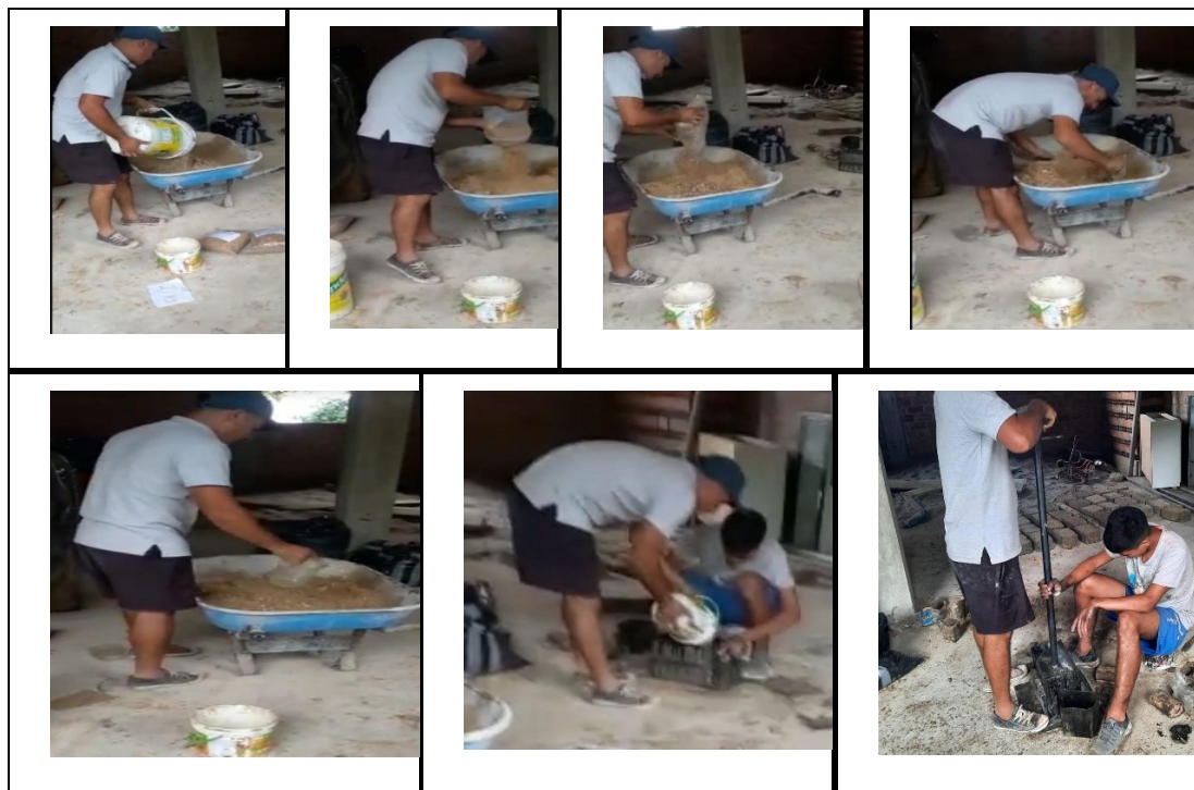
Figura 52: Elaboración de adobe compactado con viruta de madera y pajilla de arroz.
