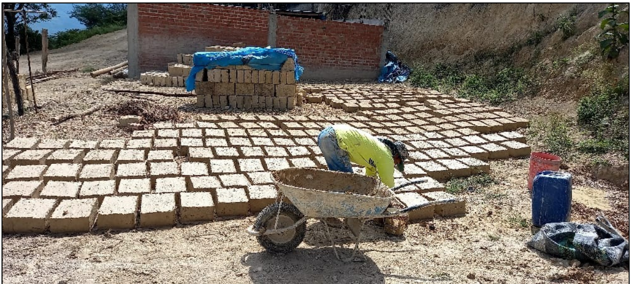
Figura 39: Elaboración y secado de los adobes.
