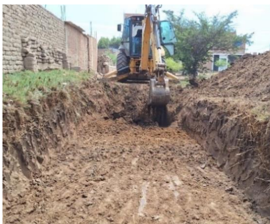
Fig. 94. Excavación de tramo con retroexcavadora
