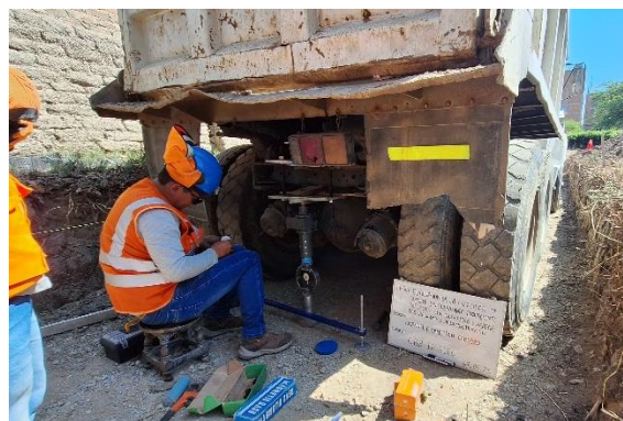
Fig. 107. Instalación del equipo CBR in situ.
