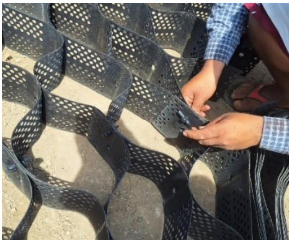
Fig. 96. Instalación de uniones en T para geoceldas.
