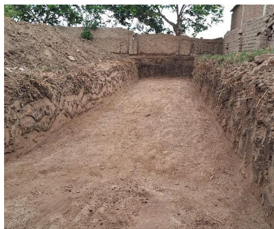
Fig. 95. Subrasante nivelada y compactada.
