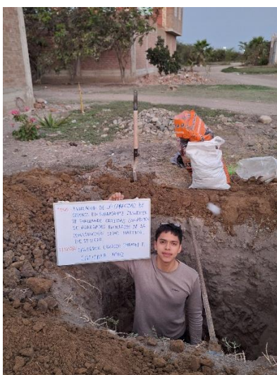
Fig. 18. Excavación de calicata en zona de estudio.
