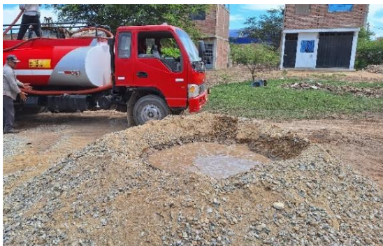
Fig. 100. Adición del porcentaje de agua para la combinación 60% AR+40% AF.
