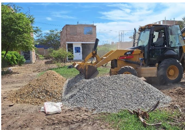
Fig. 98. Mezclado de 5m 3 agregado reciclado y 4m 3 afirmado.
