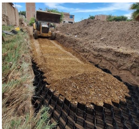
Fig. 102. Llenado de geoceldas con maquinaria.
