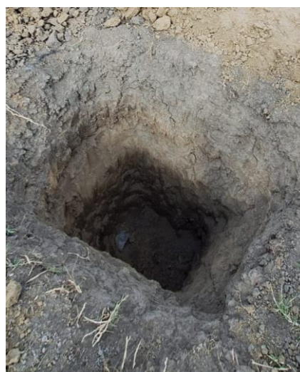
Fig. 19. Profundidad de la excavación
