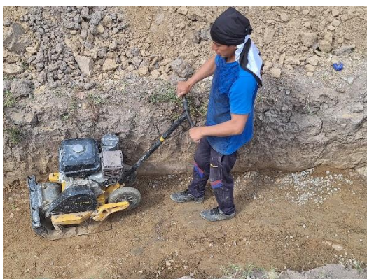
Fig. 87. Compactación del tramo experimental.
