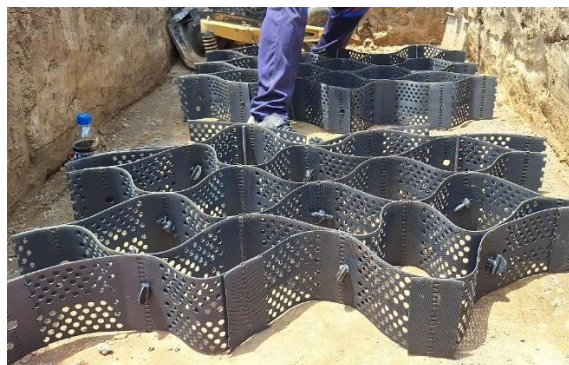
Fig. 82. Instalación de geoceldas.
