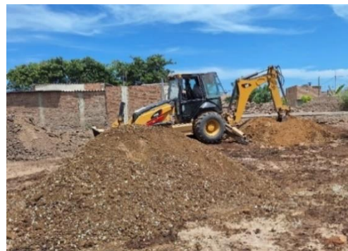
Fig. 101. Batido de los materiales granulares humedecidos.
