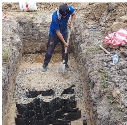
Fig. 86. Distribución homogénea del material.
