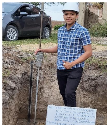
Fig. 90. Posicionamiento del equipo DCP.
