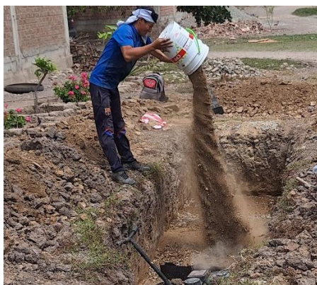
Fig. 85. Vaciado del material en geoceldas.
