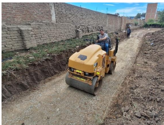
Fig. 104. Compactación del tramo con rodillo vibratorio.
