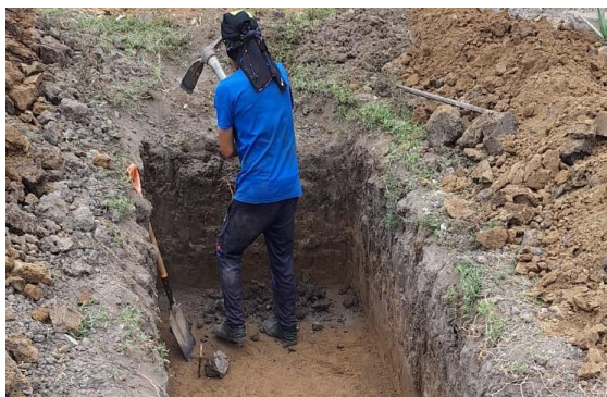
Fig. 81. Excavación de tramo experimental.
