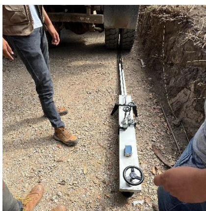
Fig. 110. Armado de Viga Benkelman.
