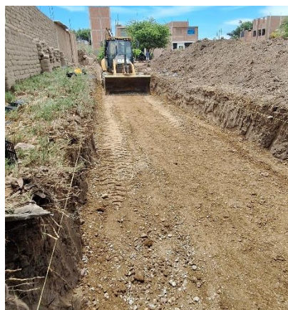
Fig. 103. Nivelación del material granular.
