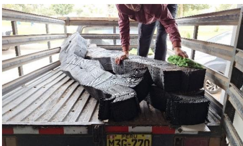
Fig. 17. Transporte de geoceldas hacia nuestra localidad.
