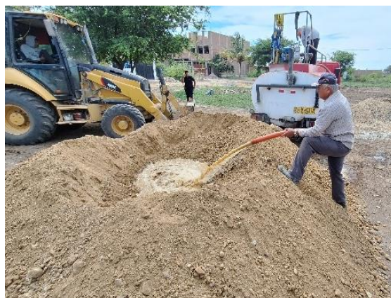
Fig. 99. Adición del porcentaje de agua para el afirmado.
