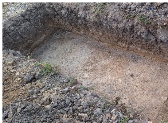
Fig. 88. Capa reforzada con geoceldas compactada para ensayo DPC.
