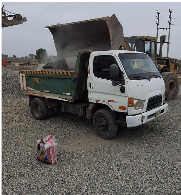
Fig. 48. Transporte del agregado reciclado triturado hacia la zona de estudio.
