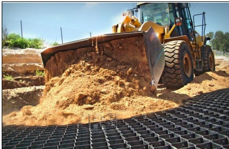
Fig. 9. Sistema de confinamiento celular (geoceldas) [29].
