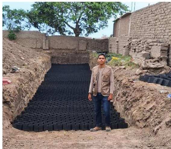
Fig. 97. Tendido de geoceldas en el tramo.
