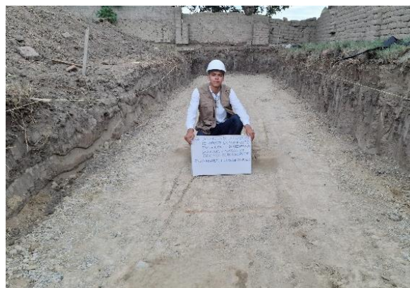
Fig. 105. Capa reforzada con geoceldas lista para ensayos de campo.
