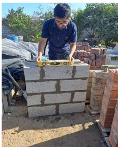
Imagen 16: Elaboración de muretes, verificación de niveles
