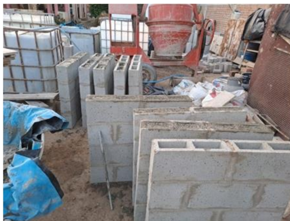
Imagen 17: Muretes rellenos con grout grueso
