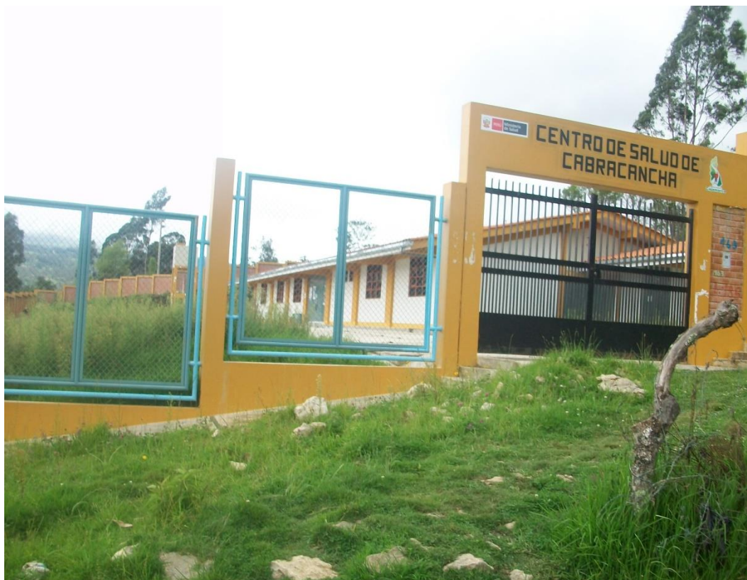
CUADRO 04. INFRAESTRUCTURA DEL P.S. CABRACANCHA
