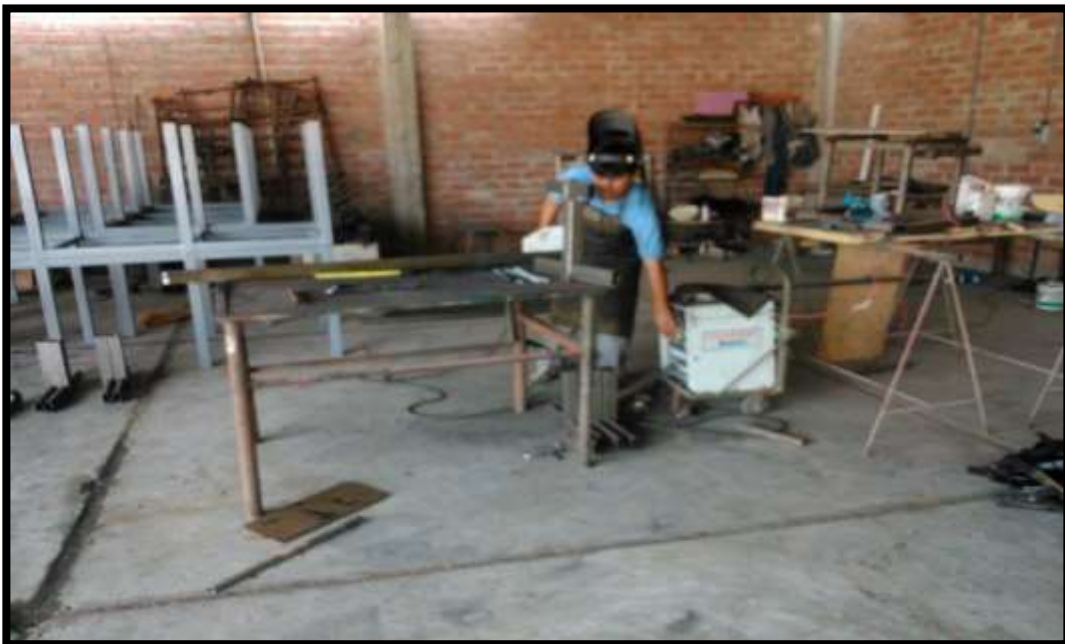
Figura 19: Proceso de soldadura Fuente: La empresa.
