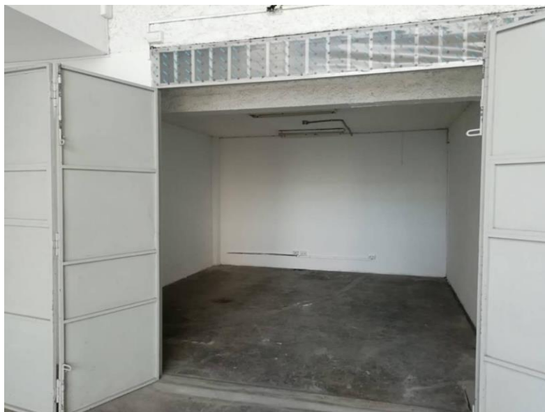
Ilustración 2. Interior del Almacén
