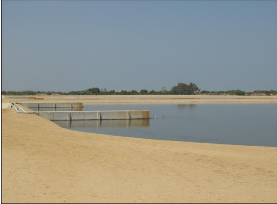
Fig. 29. Lagunas de estabilización anaeróbicas primarias.
