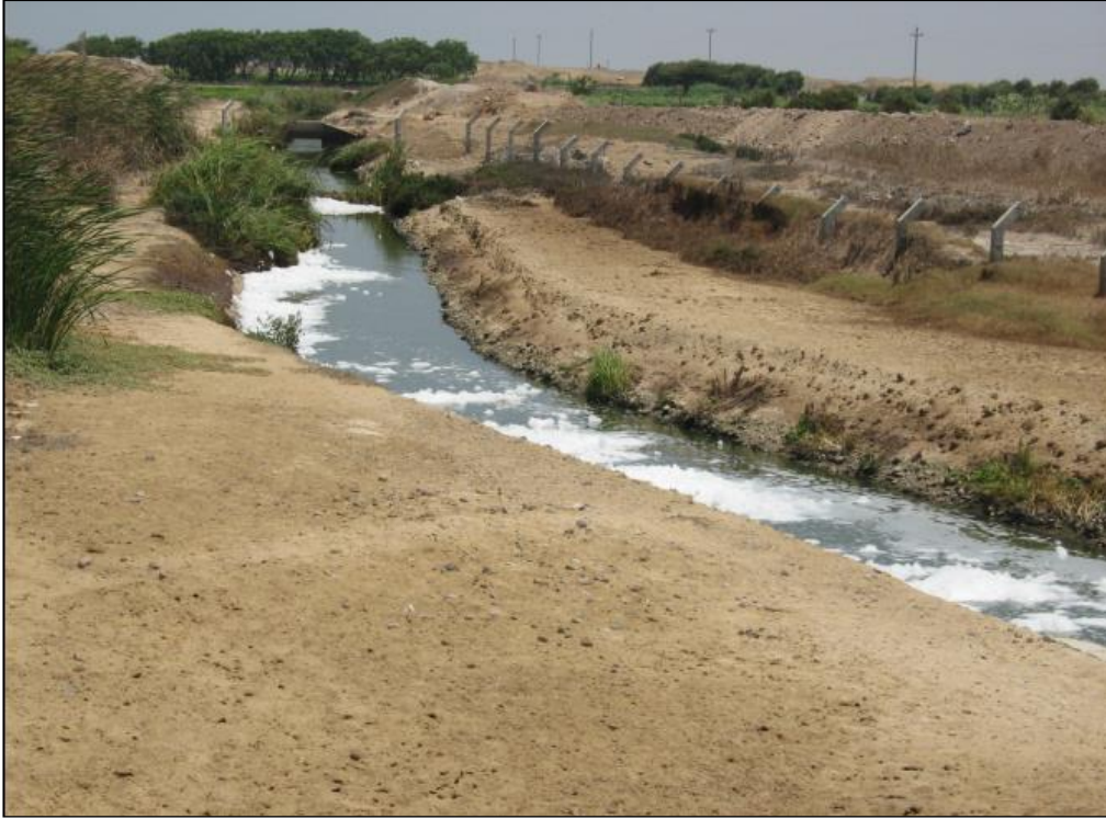
Fig. 33. Canal de riego para los agricultores.
