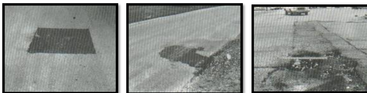
Ilustración 12. Baches y zanjas separadas: L, M y H
