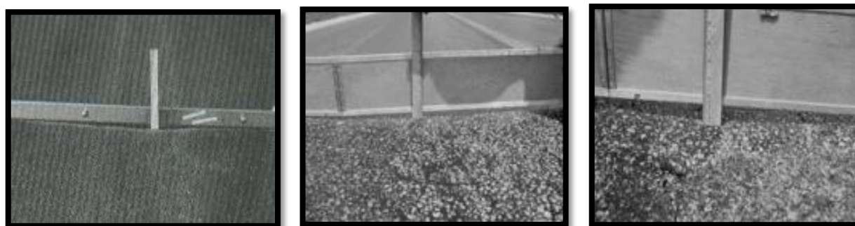
Ilustración 16. Ahuellamiento: L, M y H
