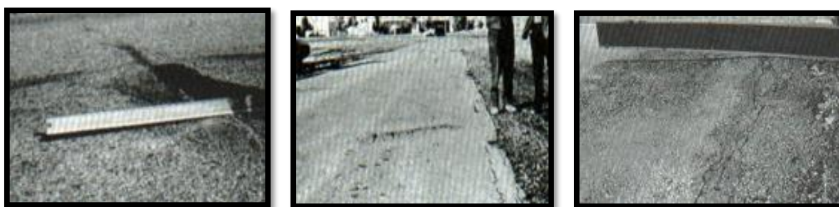
Ilustración 5. Abultamientos y hundimientos: L, M y H
