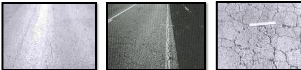
Ilustración 2. Piel de cocodrilo: L, M y H
