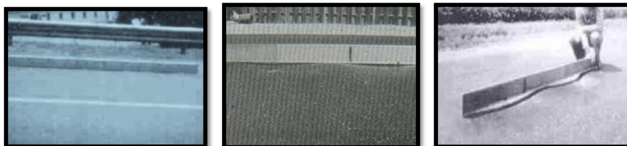
Ilustración 6. Corrugaciones: L, M y H
