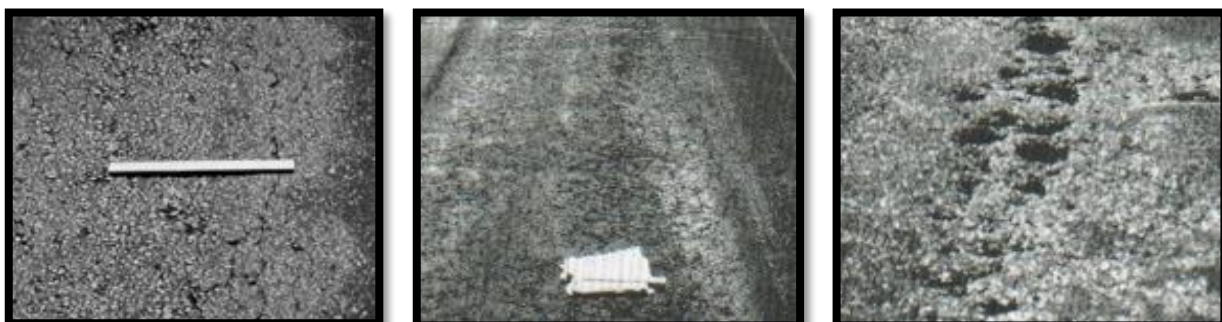
Ilustración 20. Desprendimiento de agregados: L, M y H
