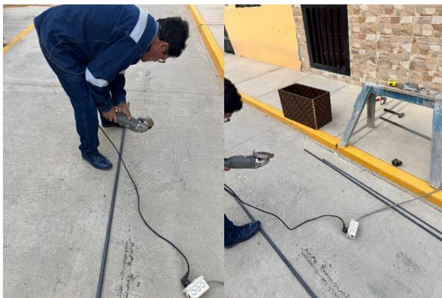
Fig. 26. Corte de barras de acero para armado de viga
