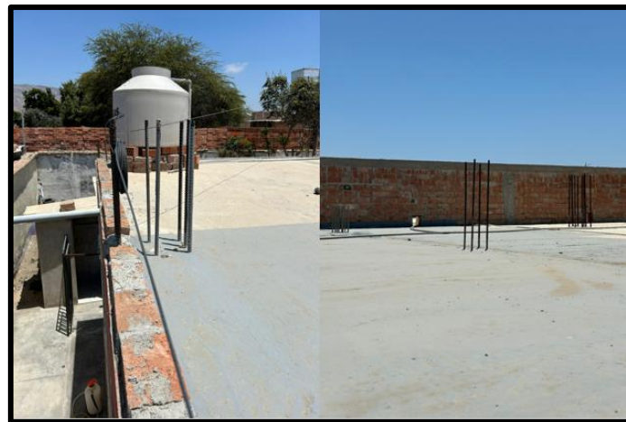
Fig. 91. Mechas de acero estructural del módulo 03.
