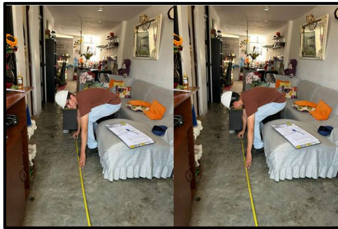
Fig. 81. Medición de muros portantes en vivienda de albañilería.
