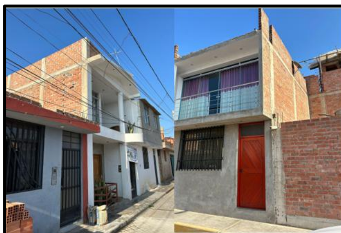
Fig. 29. Edificaciones de albañilería en la zona nor-este de Reque.
