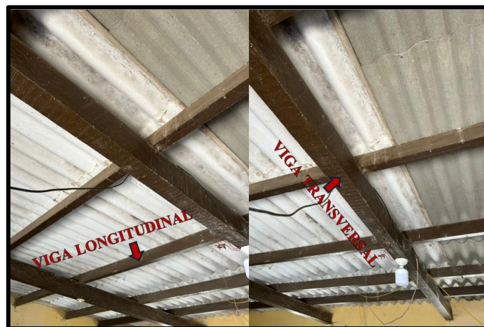
Fig. 70. Vigas en el módulo 01 de adobe.
