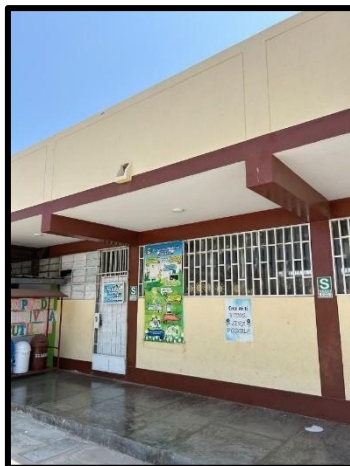
Fig. 93. Vista de columnas posibles a fallo por corte.
