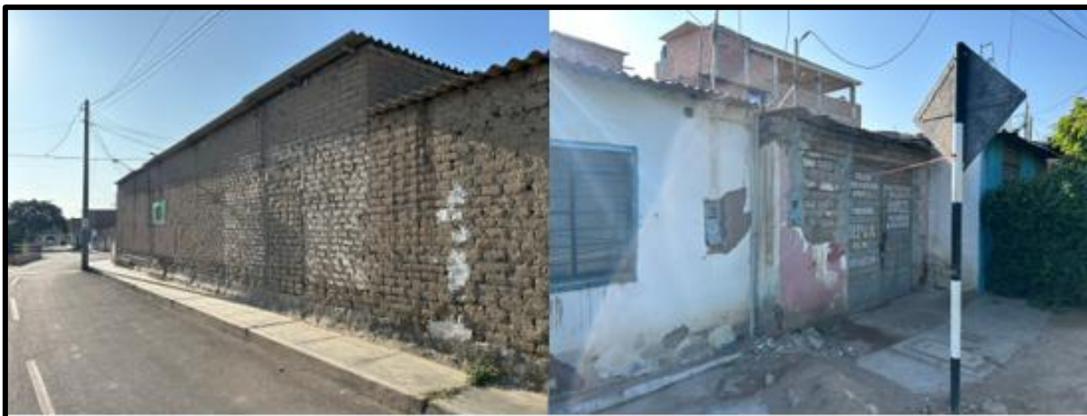
Fig. 28. Edificaciones de adobe en la zona nor-este de Reque.
