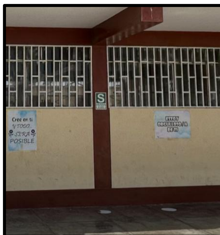
Fig. 138. Columna ubicada en eje E-E.
