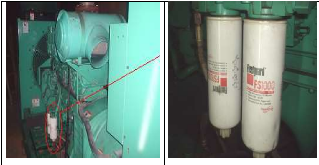
Figura N° 27: Sistema de inyección.
