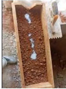
Fig. 29. Colocación de C444 en 1:4. Fuente: Propia
