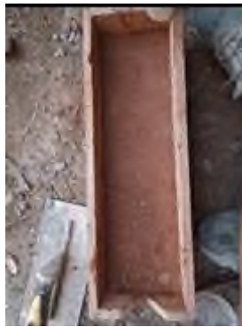
Fig. 30. Suelo después del compactado. Fuente: Propia
