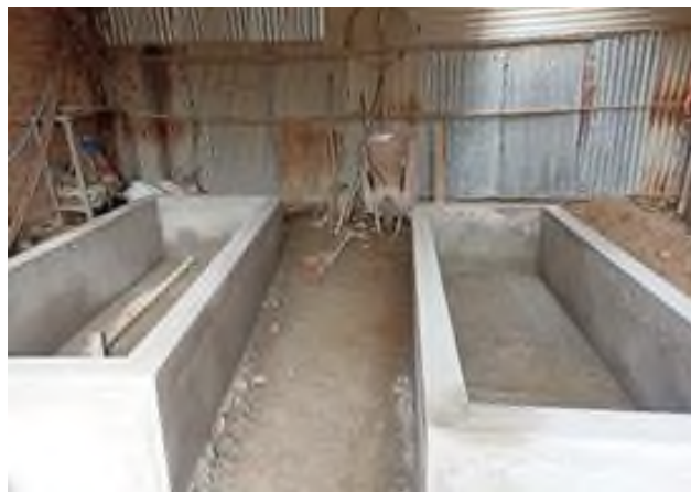
Fig. 54. Proceso de Construcción de Cuneta. Fuente: Propia
