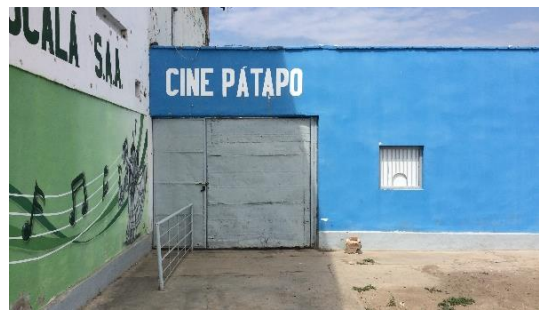
Imagen 54 - Espacios "E", Autocine. Fuente: Propia.
