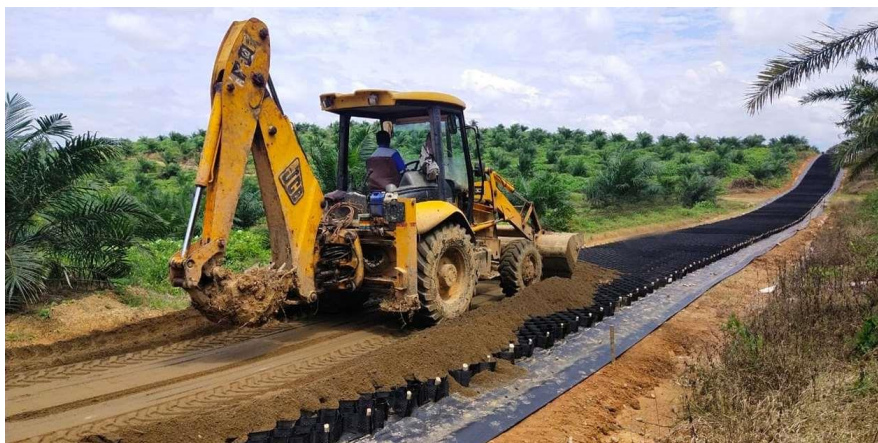
Figura 4. Estabilización con uso de geo sintéticos. Fuente: Soberón [33]
