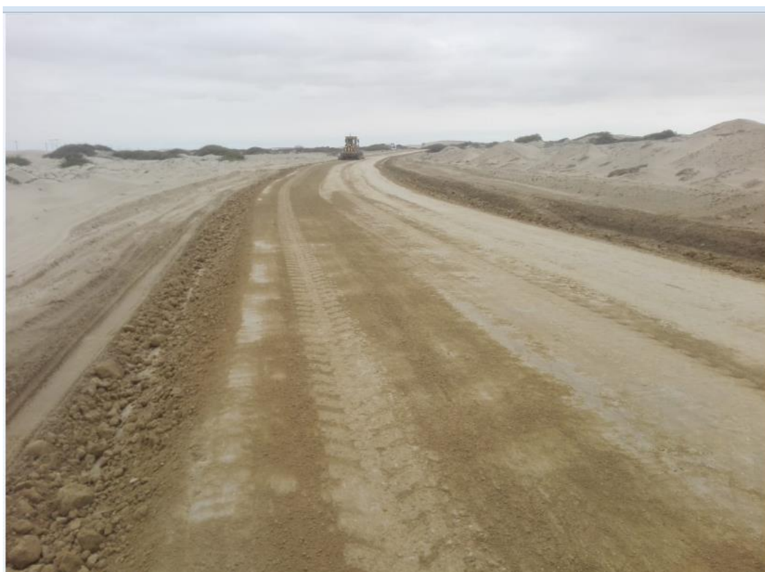
Ilustración 13. Conformación de la superficie sin aporte de material
