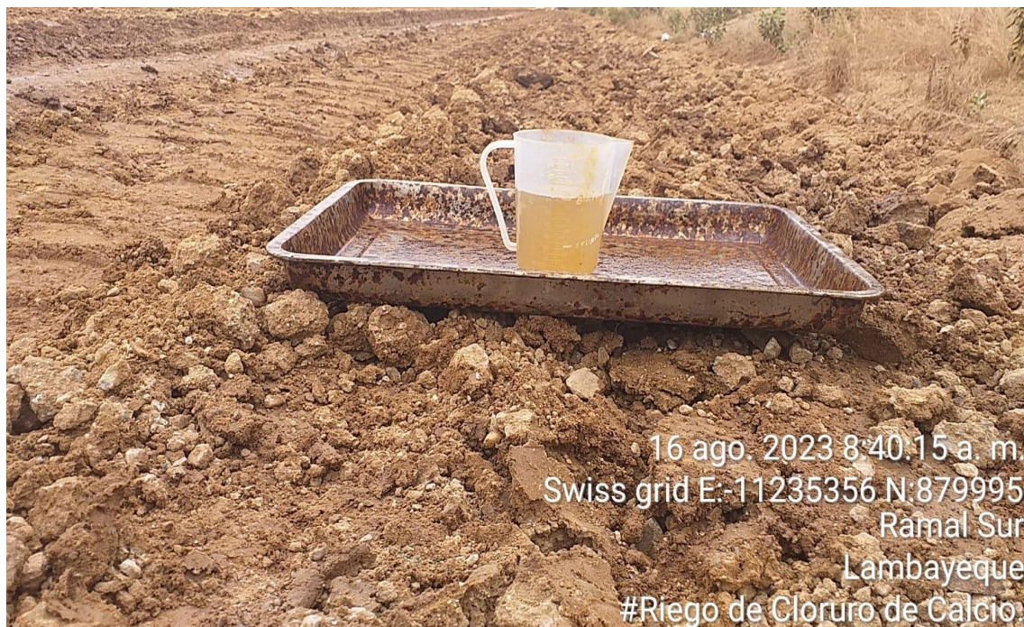
Ilustración 18. Control de dosificación en aplicación de cloruro de calcio
