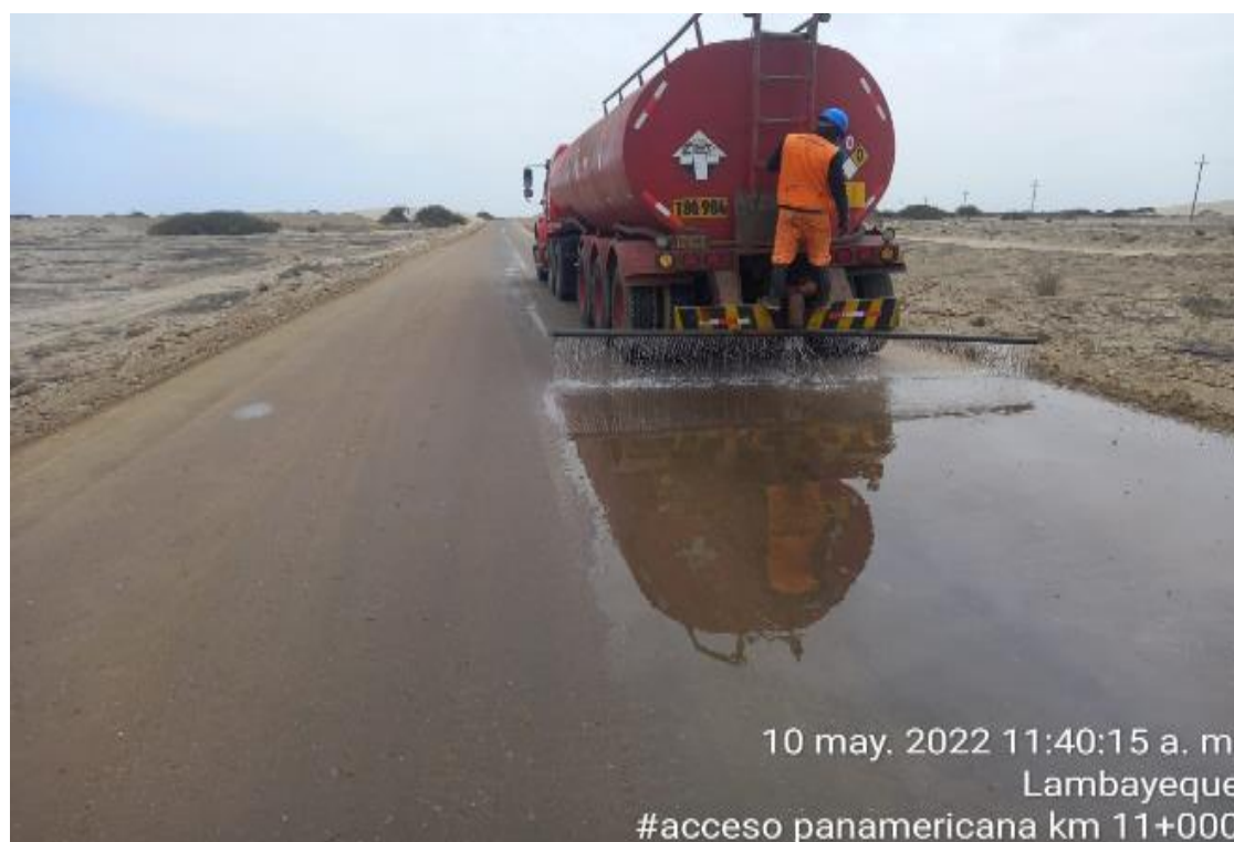
Ilustración 17. Sellado con cloruro de calcio en perfilado de la superficie sin aporte de material mas cloruro de calcio
