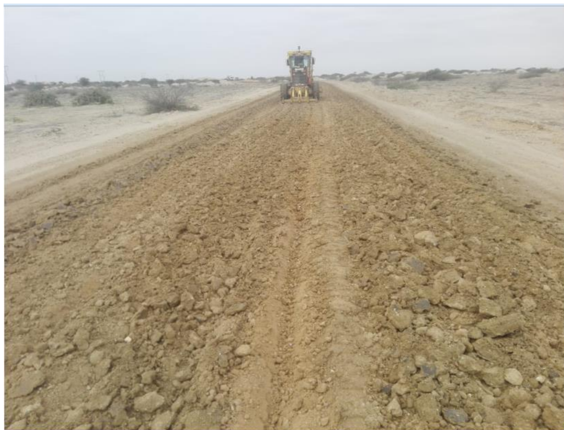
Ilustración 11. Escarificado de la Superficie sin aporte de material
