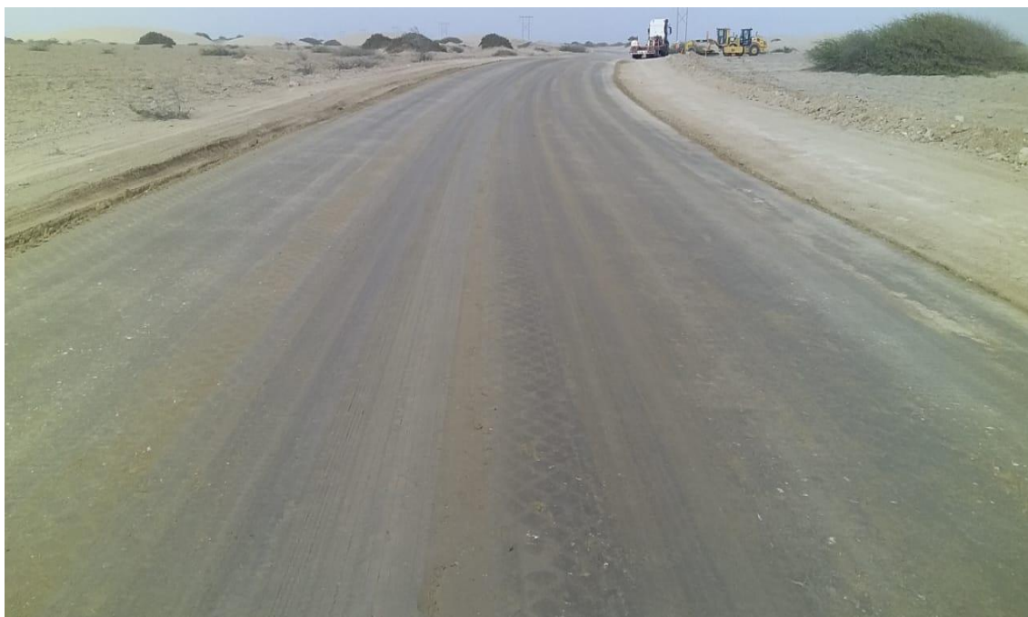
Ilustración 3. Estado bueno de los caminos en tramos con cloruro de calcio
