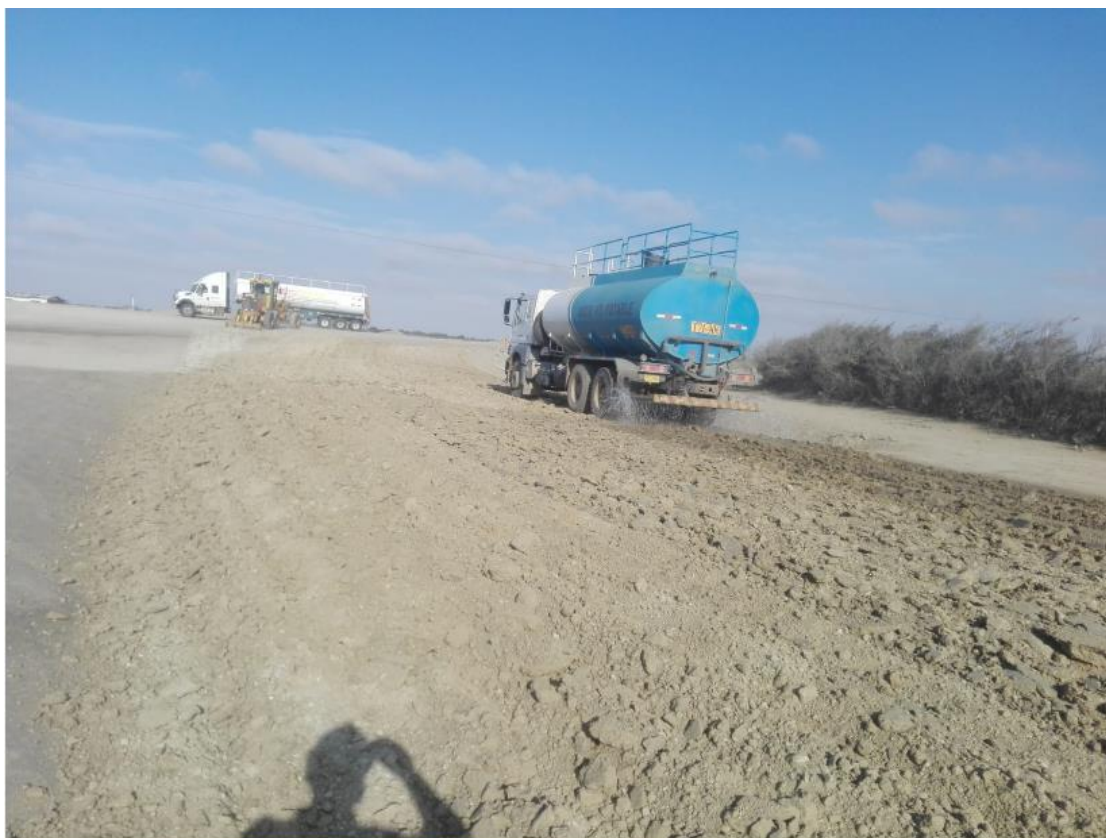
Ilustración 12. Riego en perfilado de la superficie sin aporte de material
