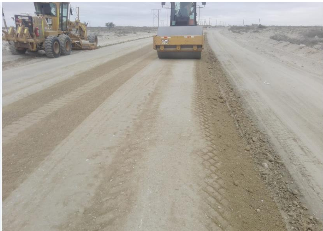
Ilustración 14. Compactación de la Superficie sin aporte de material
