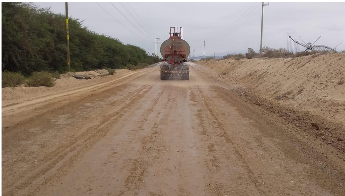
Ilustración 10. Riego de Accesos con Cisterna de agua
