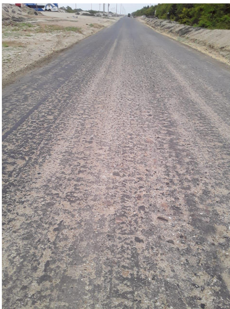
Ilustración 6. Estado Regular en tramos con cloruro de calcio
