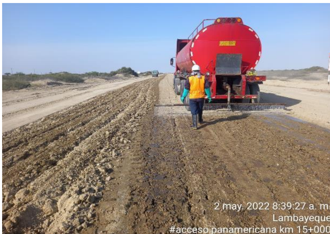
Ilustración 16. Aplicación de cloruro de calcio en Perfilado de la superficie sin aporte de material más cloruro de calcio
