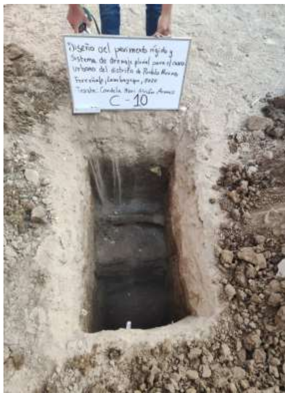
Fotografía 20: Calicata 10 - Calle Policarpio con prolong. Francisco Gonzales
