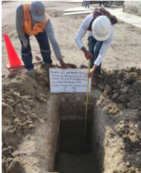
Fotografía 17: Calicata 05 – Av. Augusto B. Leguía cuadra 6
