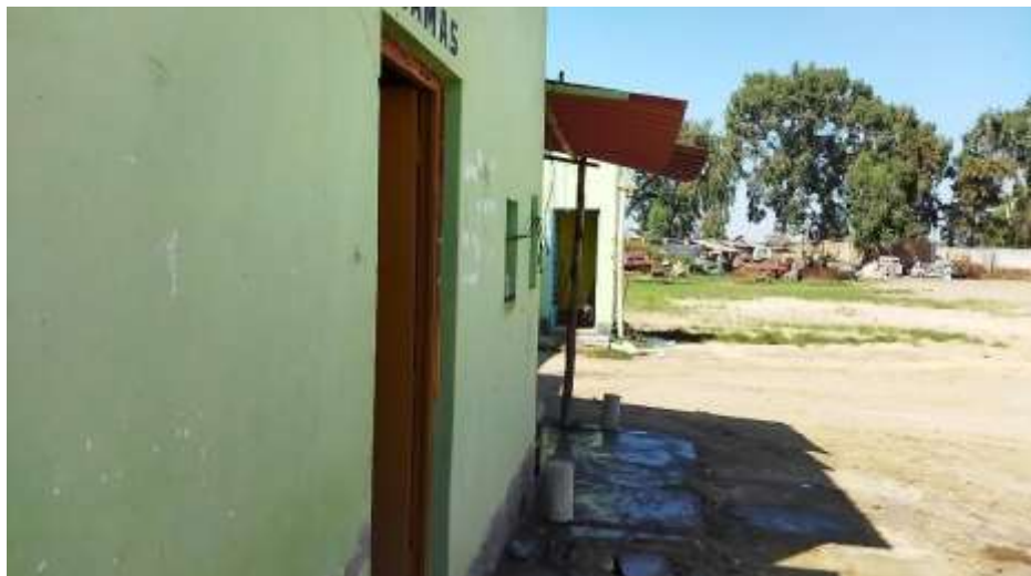
Ilustración 32 Ambiente de servicios higiénicos
