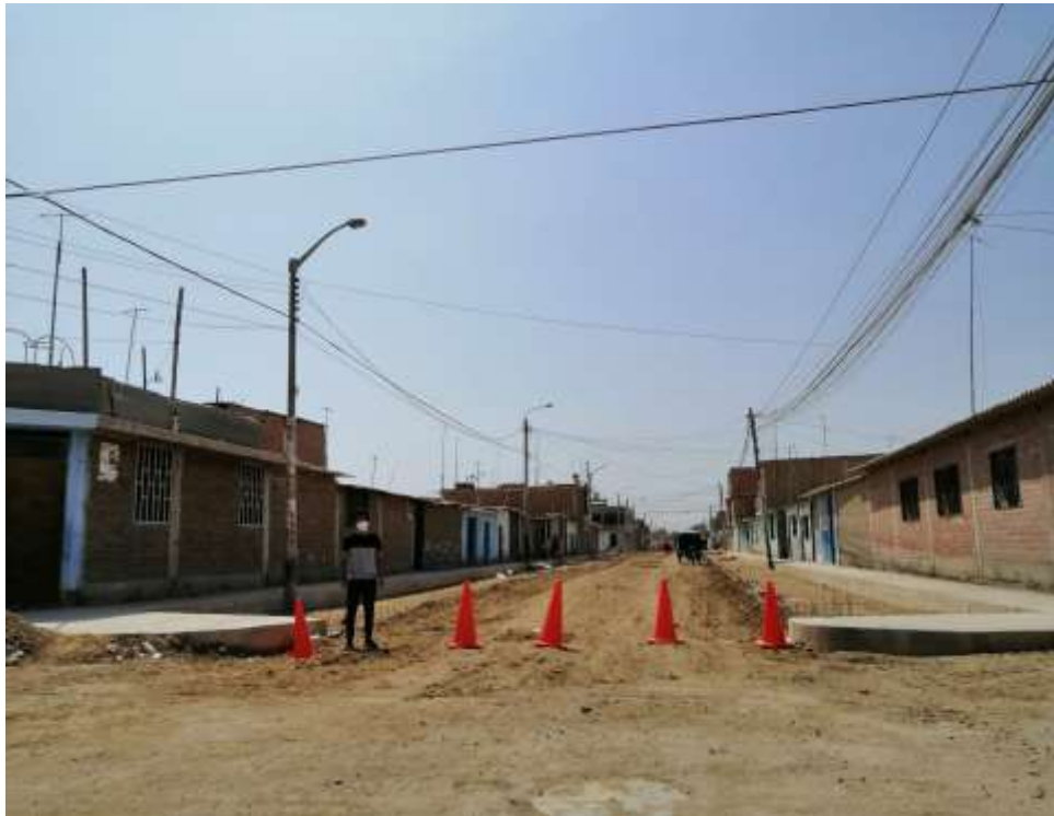
Fotografía 08: Trabajo de pavimentación 2020 Ca. Britaldo González
