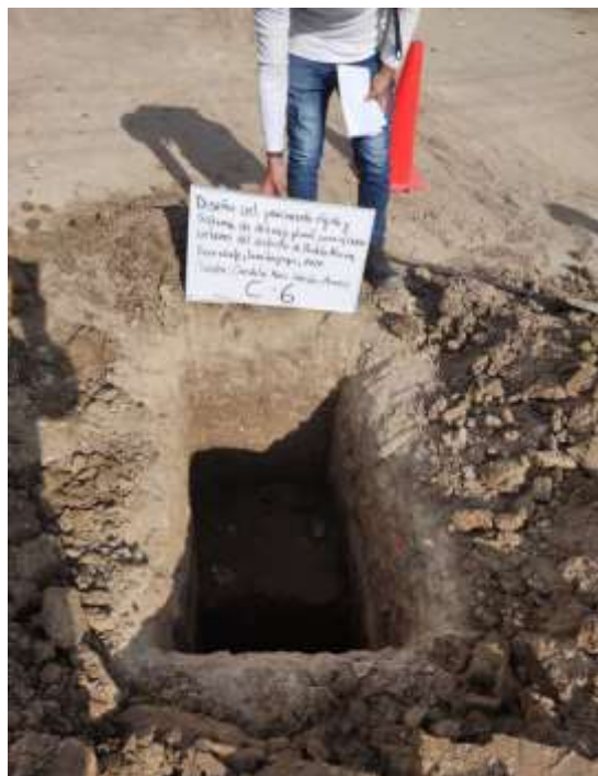
Fotografía 18: Calicata 06 – Av. Augusto B. Leguía cuadra 5
