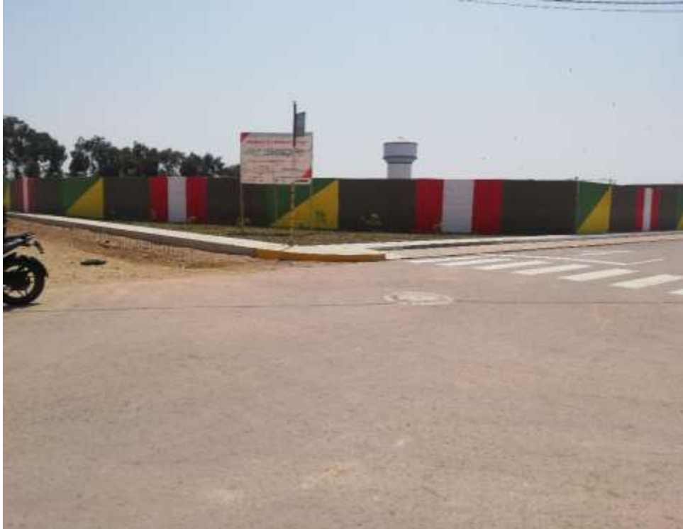
Fotografía 07: Estado actual de Ca. Alberto Exebio
