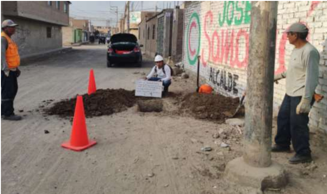
Fotografía 19: Calicata 09 - Calle Santa Lucía con prolong. Francisco Gonzales
