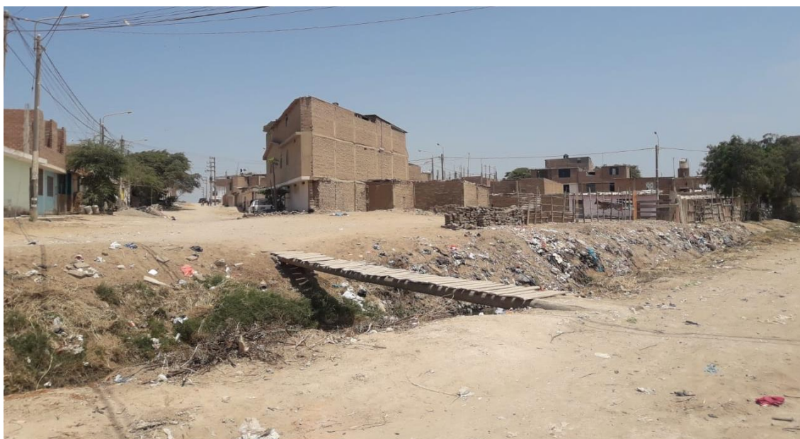
Figura 13: Puente precario de acceso que cruza la acequia Pulen, avenida el Ejército.
