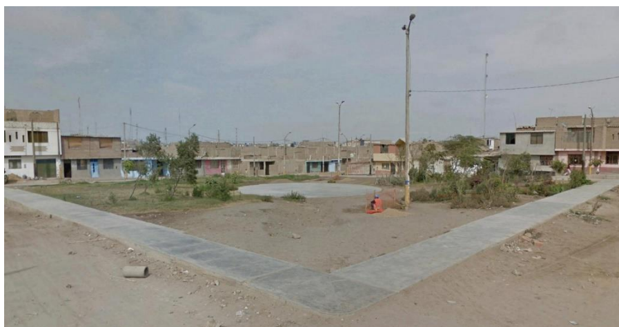
Figura 10: Parque N° 10, con déficit en el mobiliario público de descanso y vegetación parcial.
