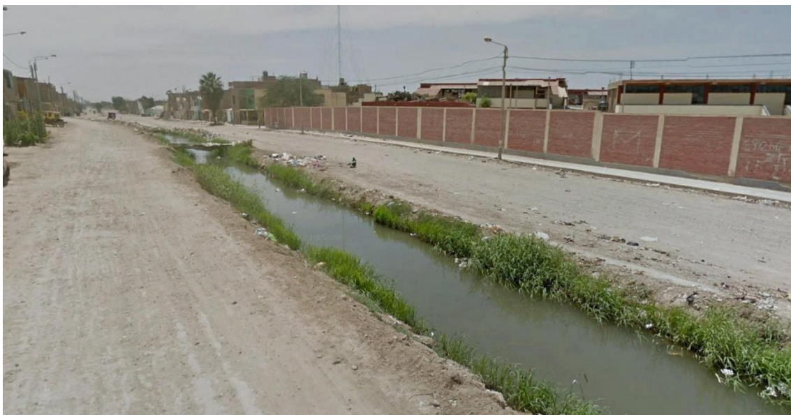
Figura 1: Bajo control de los bordes la acequia Pulen (tramo de calle María Auxiliadora)
