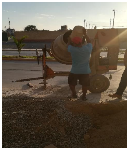
Figura 30: Elaboración de especímenes de concreto en campo Fuente: Elaboración Propia
