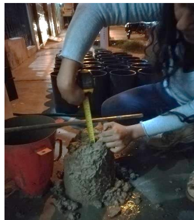
Figura 49: Slump en campo (4'')
