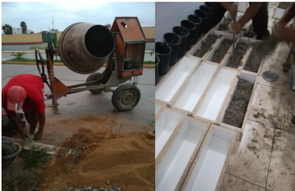
Fotografía 2. 19: Fotografías representativas de la elaboración de concreto en campo
