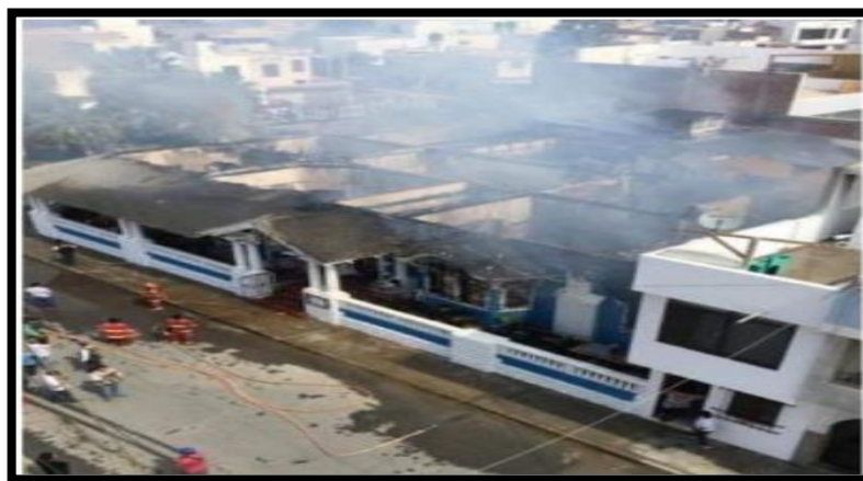
Figura 2: Casona Zoeguer Pimentel luego del incendio.
