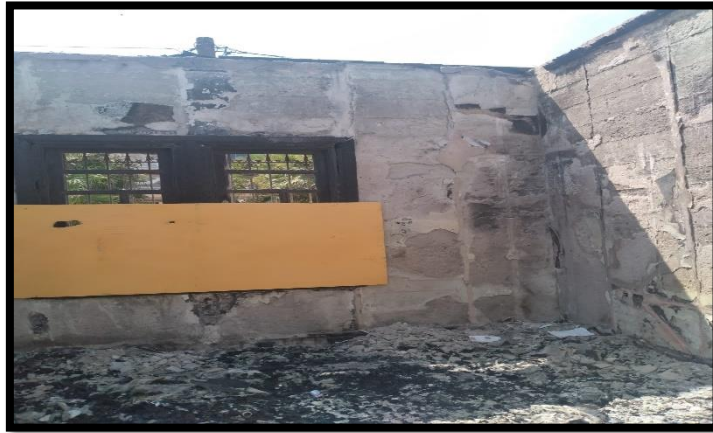
Figura 19: Muros de la Casona Zoeguer N° 01
