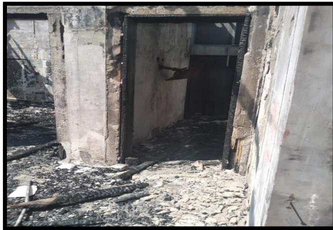
Figura 22: Muros de la Casona Zoeguer N°03
