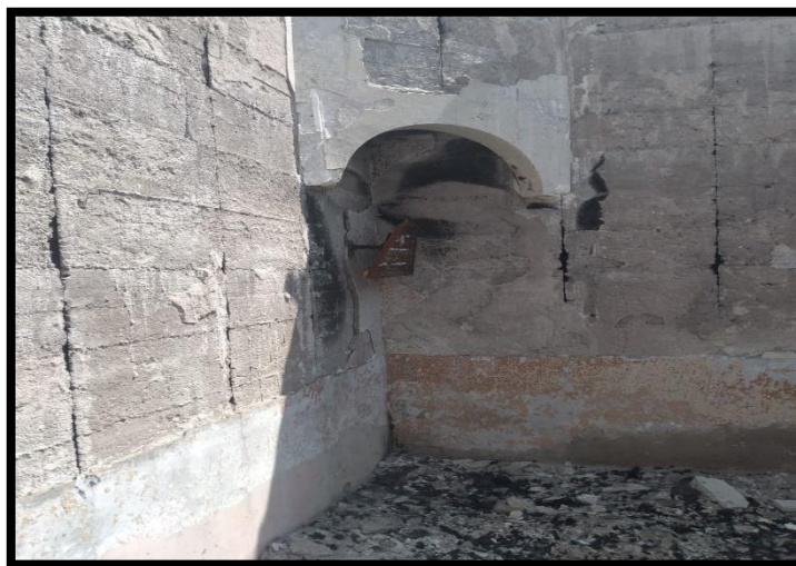
Figura 26: Fotografía de Muros con parantes de Madera
