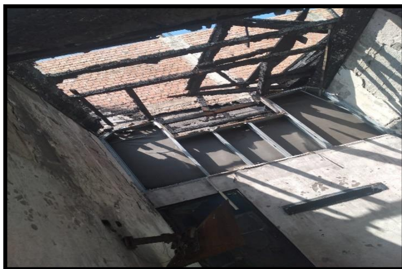
Figura 6: Techo del baño de la Casona Zoeguer
