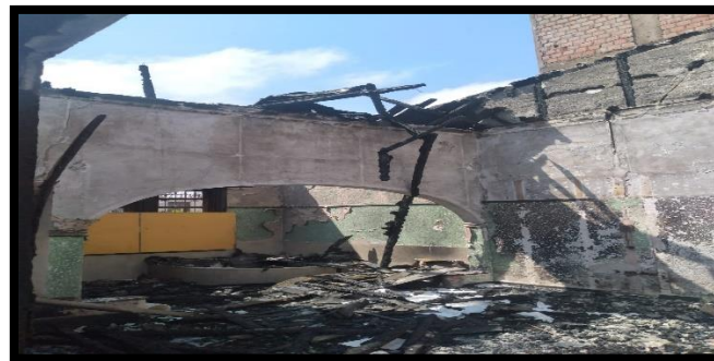
Figura 20: Muros de la Casona Zoeguer N° 02
