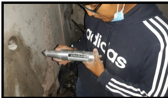
Figura N°01: Ensayo de Esclerometría.
