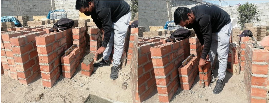
Figura N°52: Elaboración de pilas
