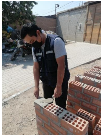
Figura N°56: Refrentado de muretes
