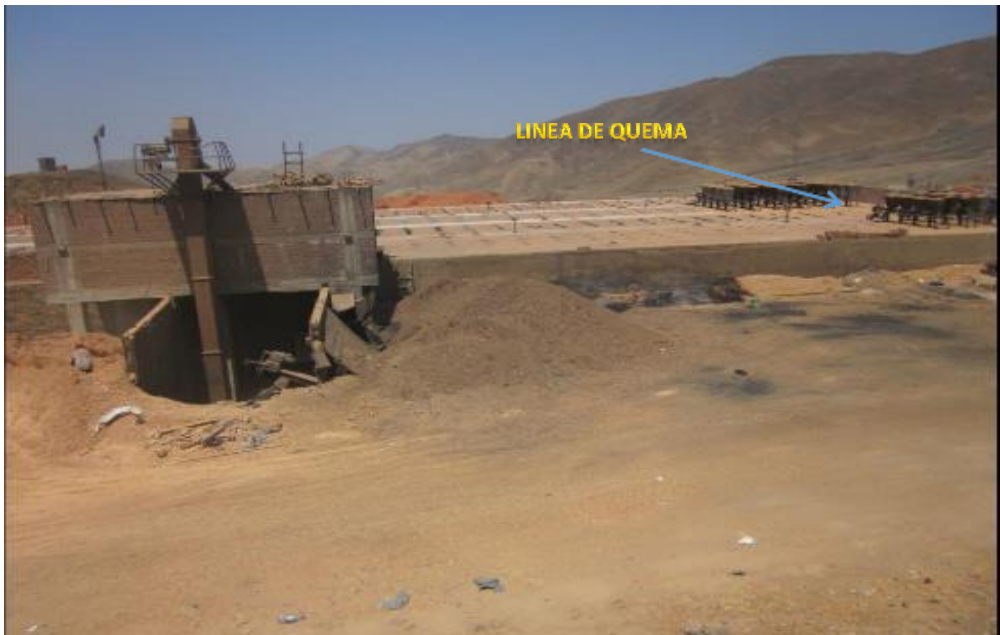
Figura 34. Funcionamiento de una línea de quema
