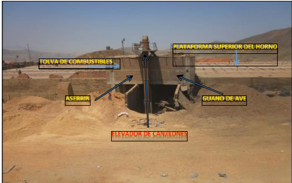
Figura 33. Hornos Hoffman – Vista de área de combustible
