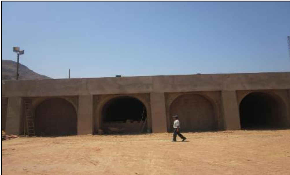
Figura 35. Detalle exterior de una línea de quema, conformada por una batería de 4 hornos Hoffman.
