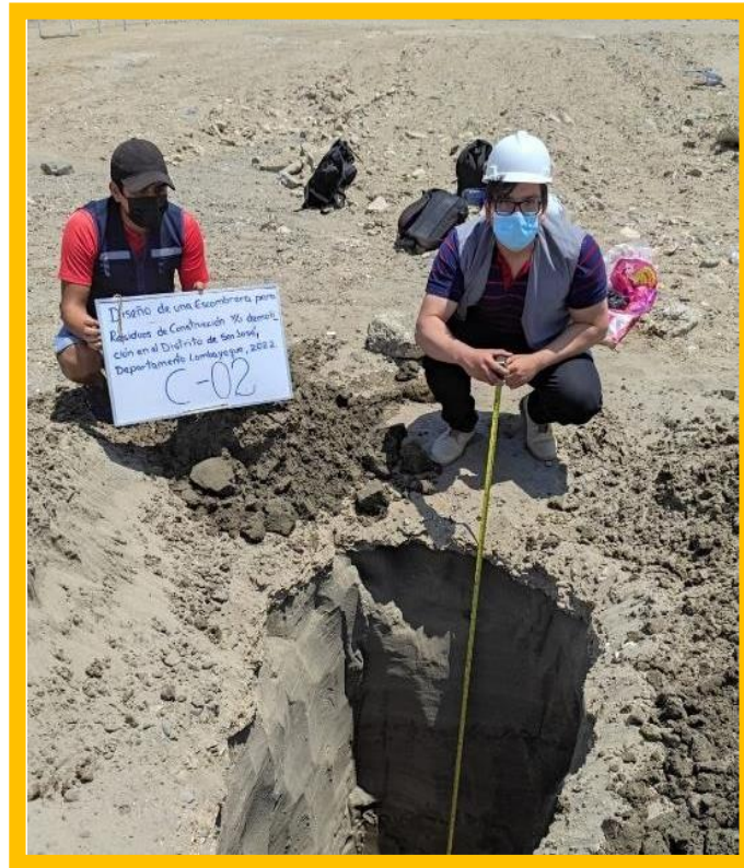
Foto N°07, Vista Calicata, C-02.
