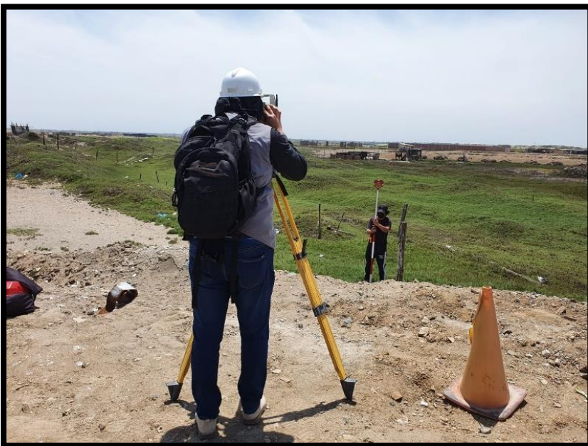
Nivelación de equipo topográfico para el levantamiento del predio.
