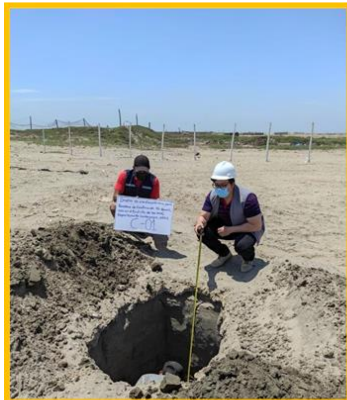
Foto N°04, Vista Calicata, C-01.
