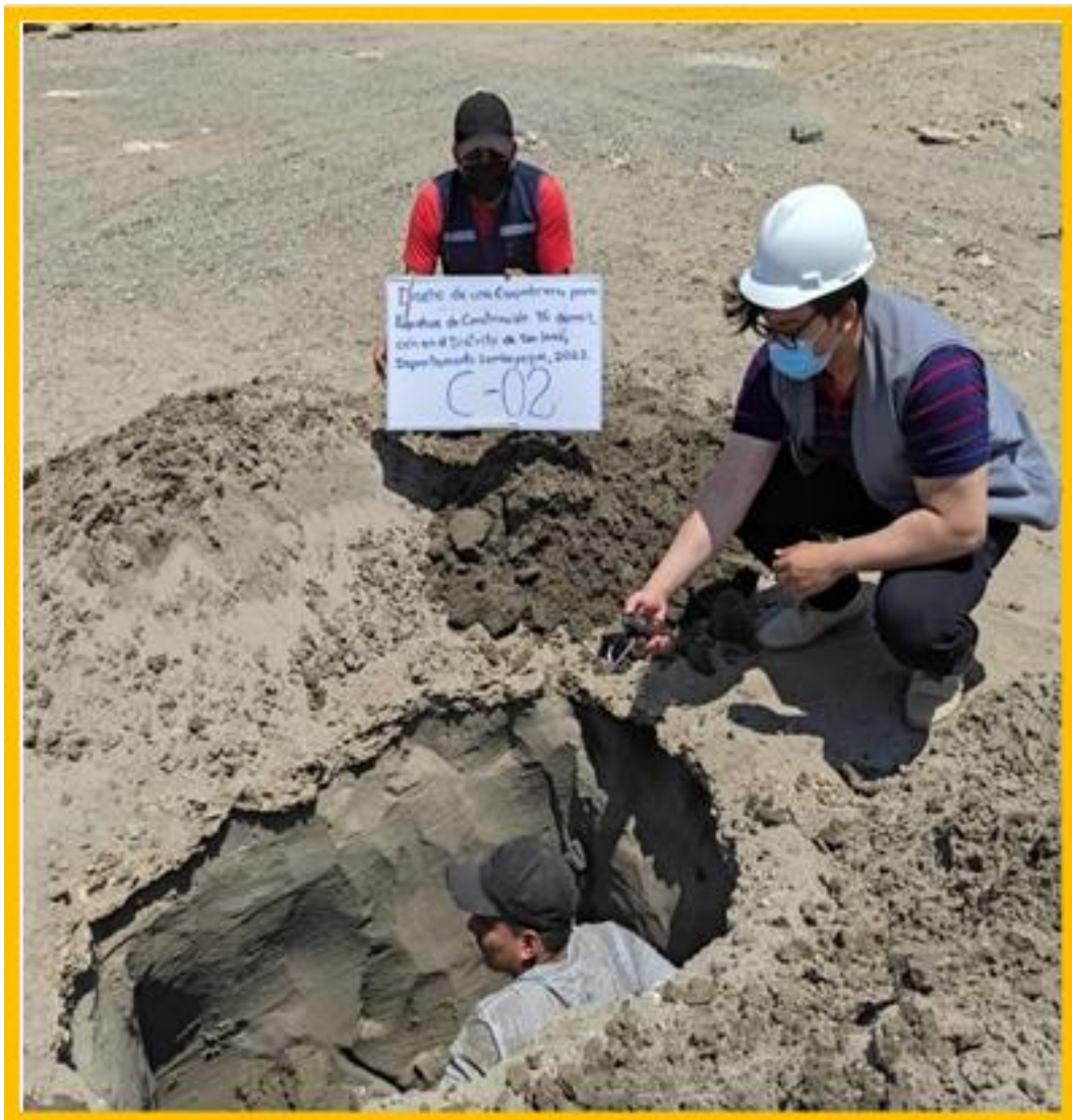
Foto N°06, Vista Calicata, C-02.
