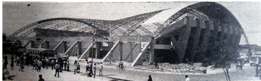
Imagen 136.Coliseo cerrado en 1971. Colocación del techo.
