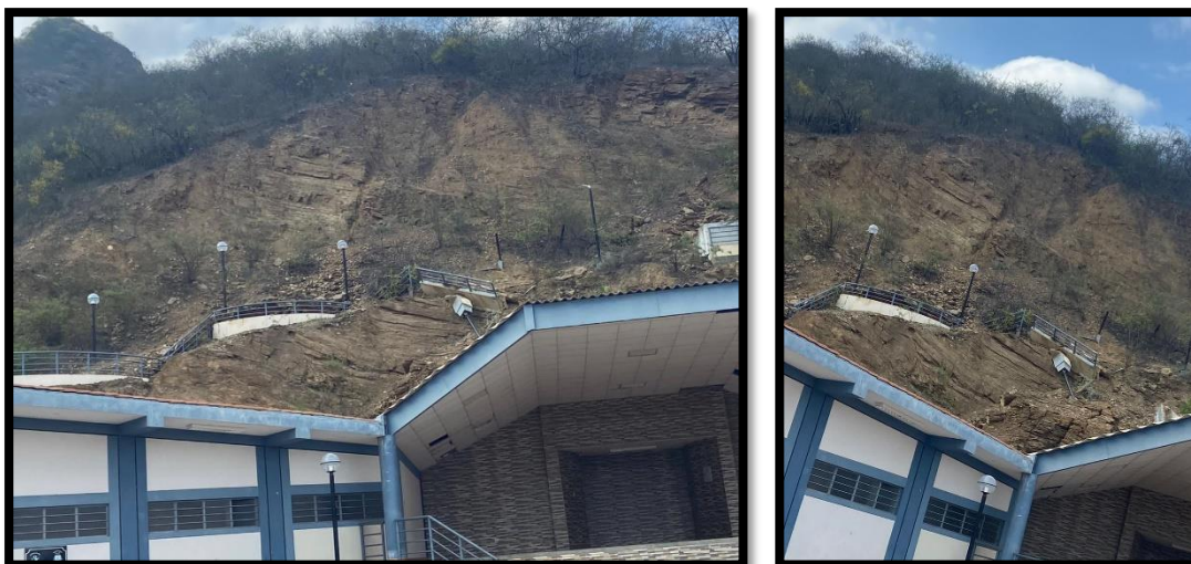
Figura 1. Daños a estructuras públicas debido al desprendimientos del talud del cerro Chalpón
