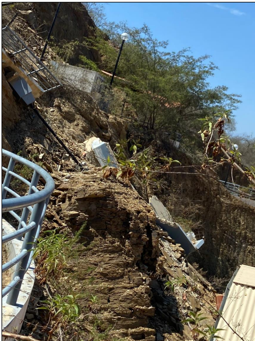
Figura 2. Vista general del deslizamiento en el cerro Chalpón
