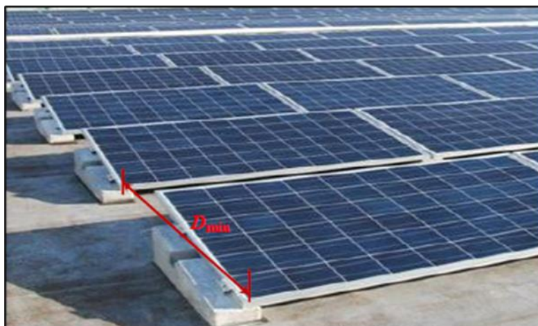
Figura 11. Distancia entre módulos solares
