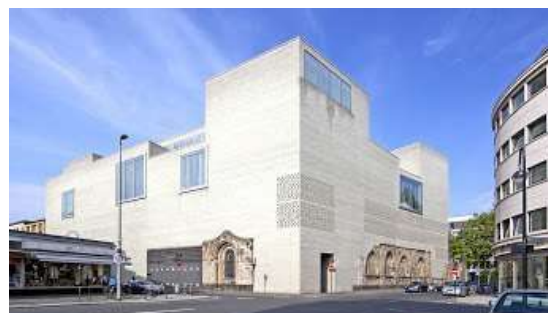
Figura 3. Vista del edificio y su envolvente
