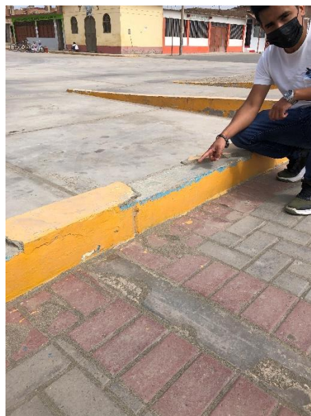
Imagen 2. Falta de Recubrimiento en Sardinel
