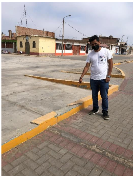
Imagen 2. Falta de Recubrimiento en Sardinel
