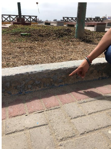
Imagen 2. Falta de Recubrimiento en Sardinel
