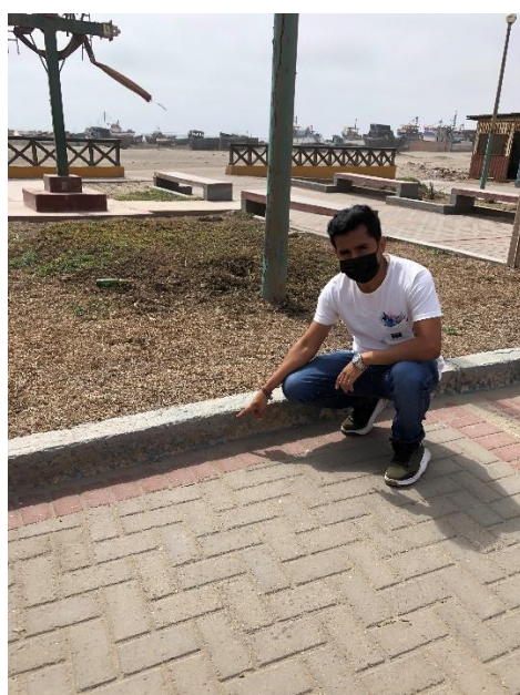
Imagen 2. Falta de Recubrimiento en Sardinel
