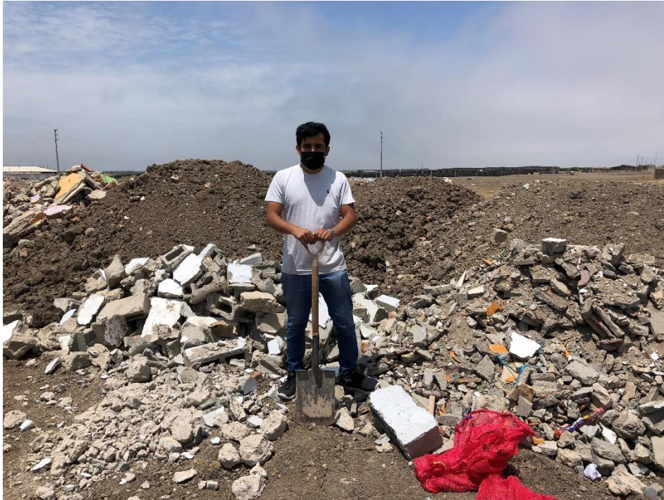
Imagen 11. Separación del Concreto Reciclado
