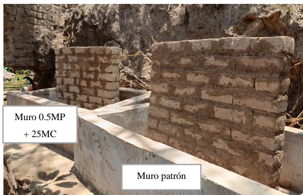
Ilustración 59 Construcción de muros para prueba de inundación simulada
