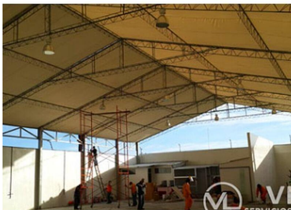
Figura 44.39. Estructura metálica y techo
