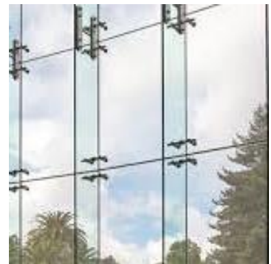
Ilustración 42. Paneles de vidrio. Fuente Propia.
