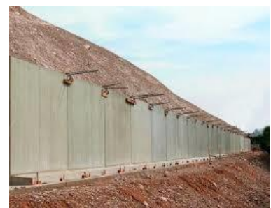
Ilustración 32. Muro de contención de concreto armado.
