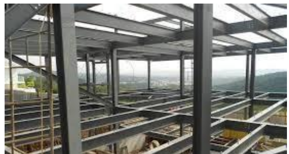
Ilustración 40. Estructura metálica. Fuente Propia.
