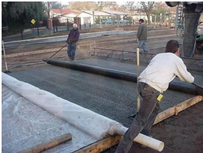
Figura 8 Compactación de regla rodillo
