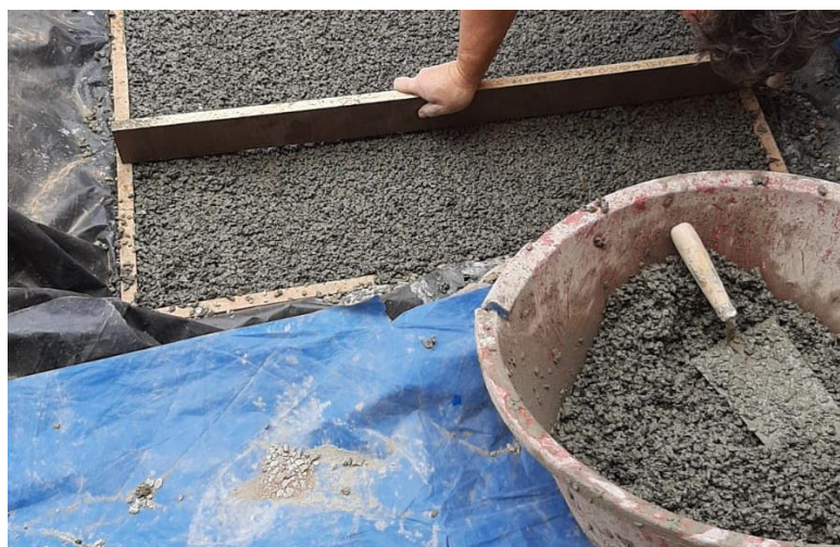
Figura 35. Enrasado de losa
