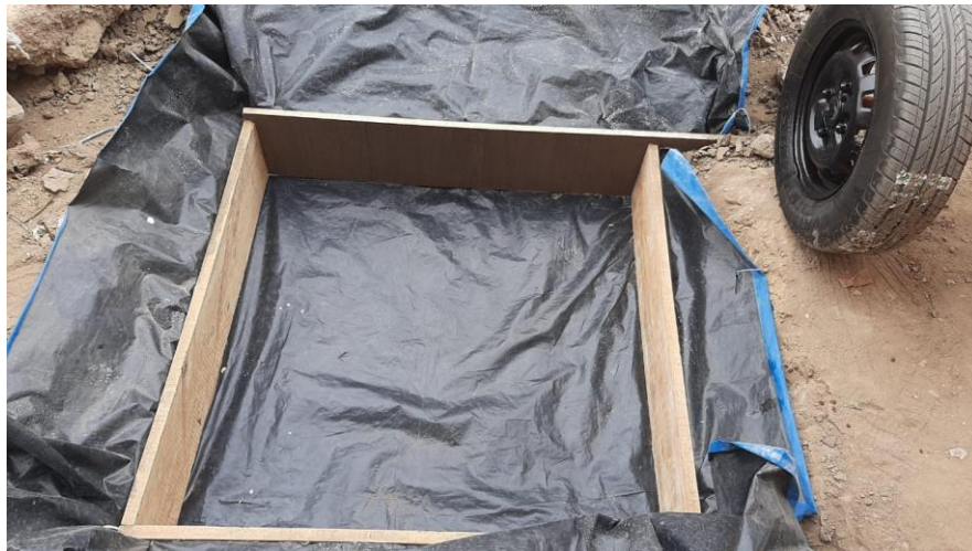
Figura 33. Encofrado de losa
