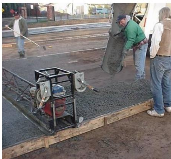
Figura 7. Empleo de Regla compactadora
