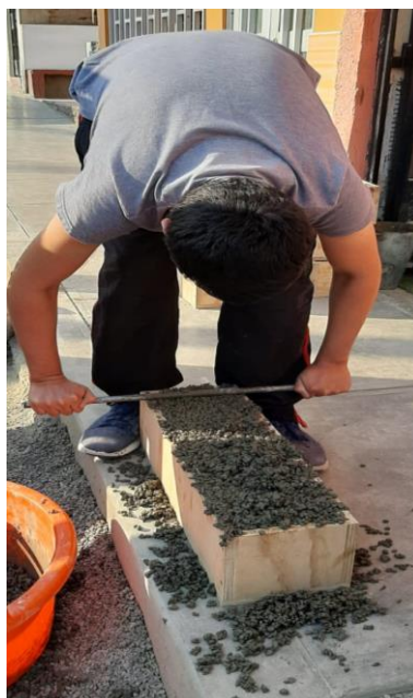
Figura 17. Enrasado de viga
