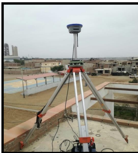
Imagen 6: Instalación y configuración de la antena base, ubicado en un el techo de una
