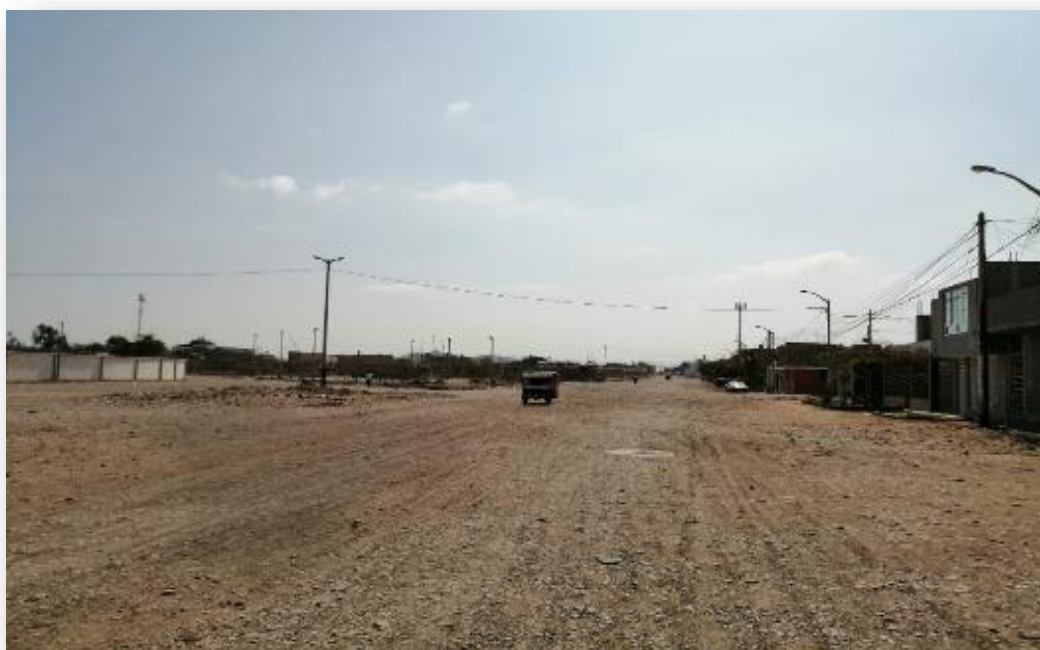
IMAGEN N° 02.06 – SITUACION ACTUAL DEL AV. MANUEL PASTOR RIOS – FUENTE: PROPIA
