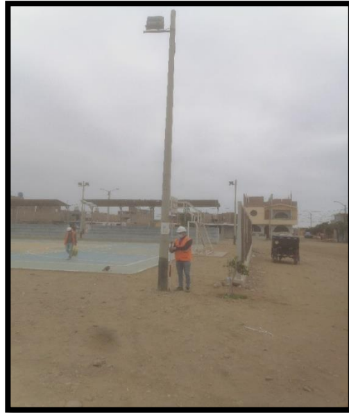
Imagen 7: Presencia de personal de topografía
